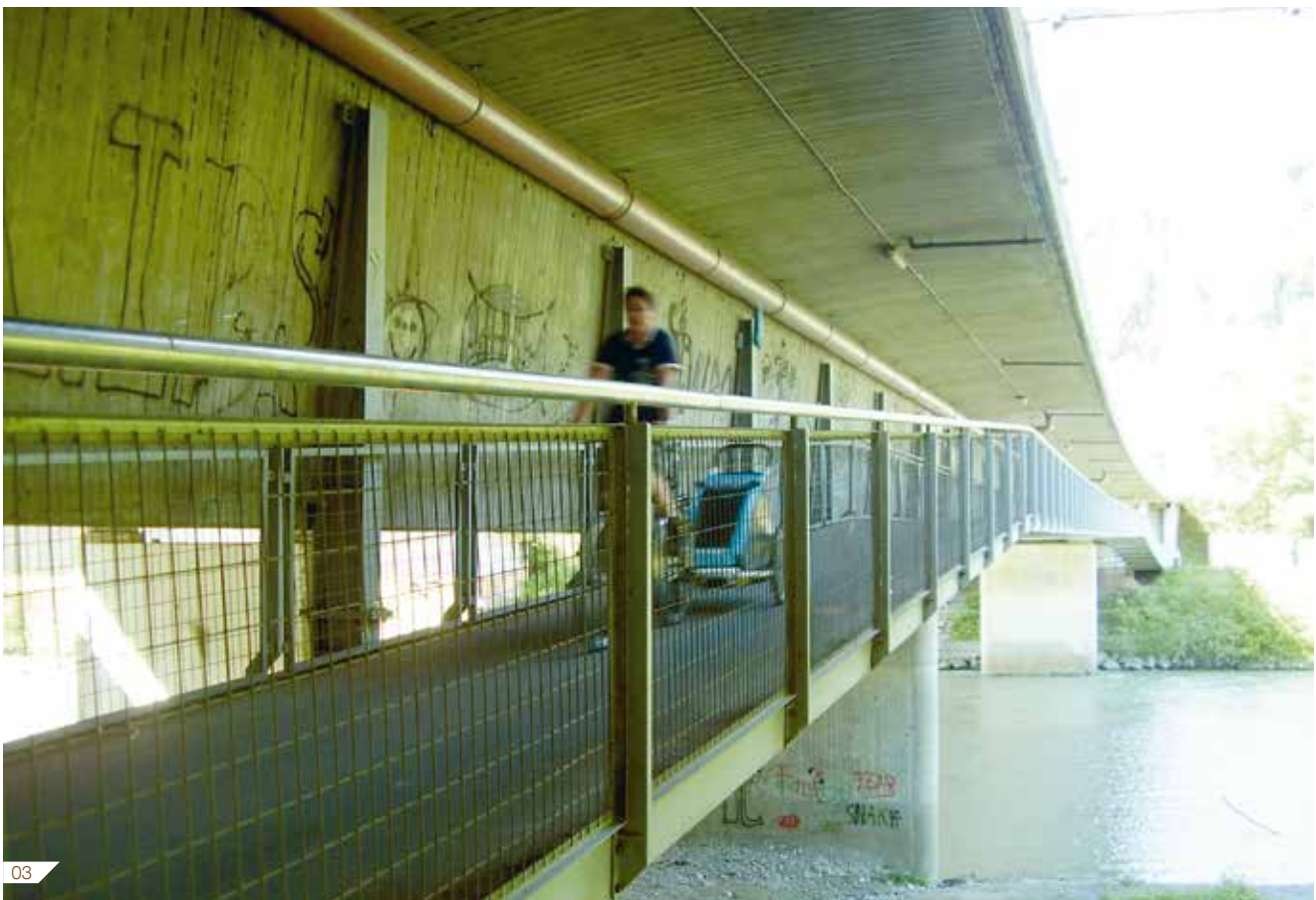
02 - 03 Fahrradbrücke unter der Autobahn 04 Fahrradbrücke Wolfurt
