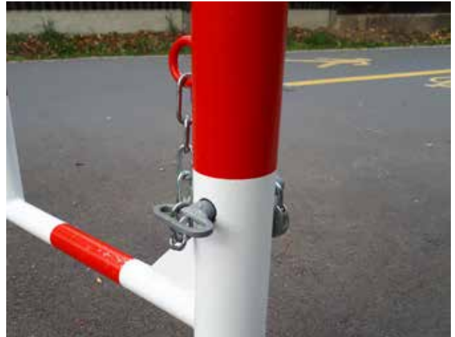
Abb. 5: Detail der Verriegelung des drehbaren Schrankenelements
