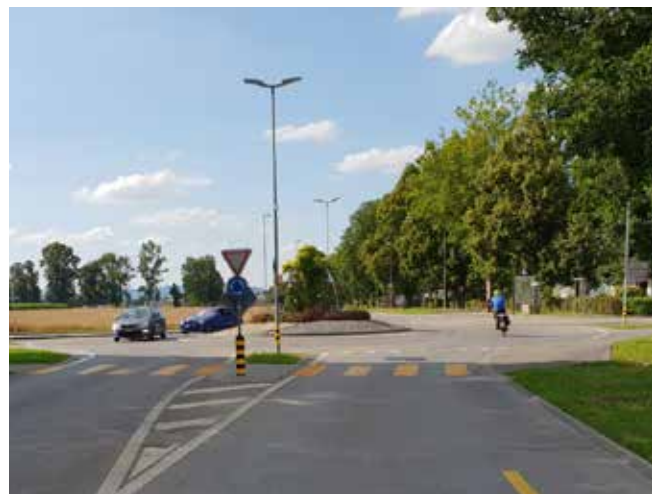
Abb. 4: Kreiseln in Thun mit zu breiten Einfahrten und zu breiter Kreisfahrbahn sowie sich überschneidenden MIV- und Velo-Achsen. (Bürgerstrasse - Allmendingenallee, Sanierungsprojekt durch B+S AG in Erarbeitung).
