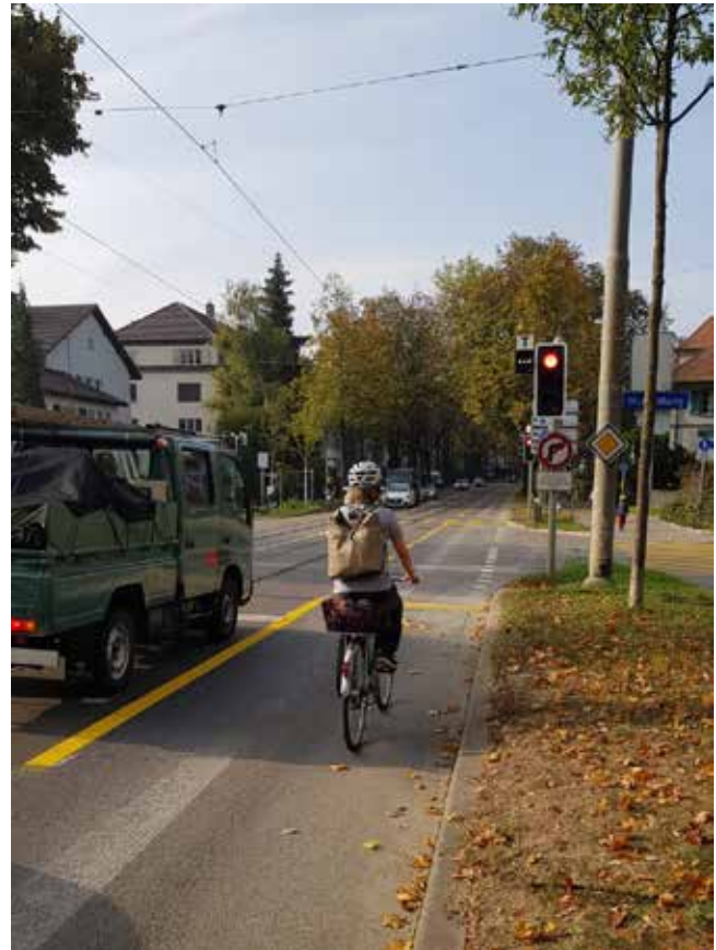
Abb. 2: Breiter Radstreifen Muristrasse. Die Neumarkierung auf rund 2.40 m Breite war verhältnismässig einfach zu erstellen.
