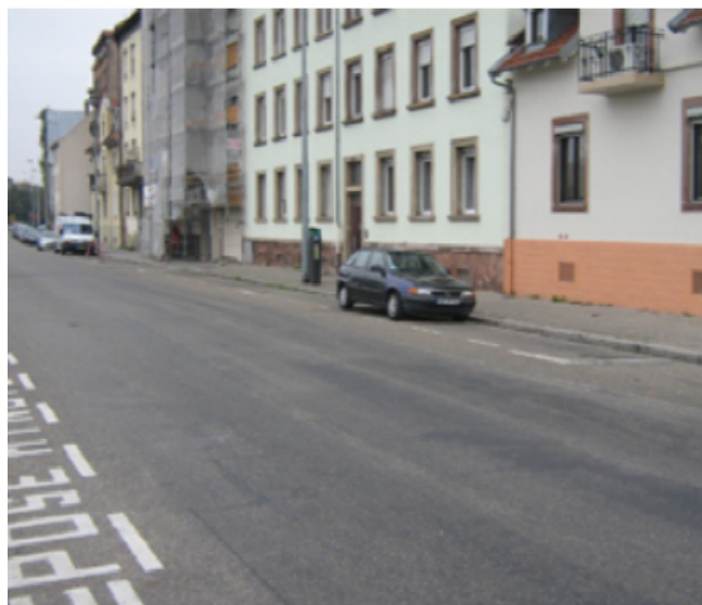
Abb.5: Rue de Fouday vor und nach der Sanierung
