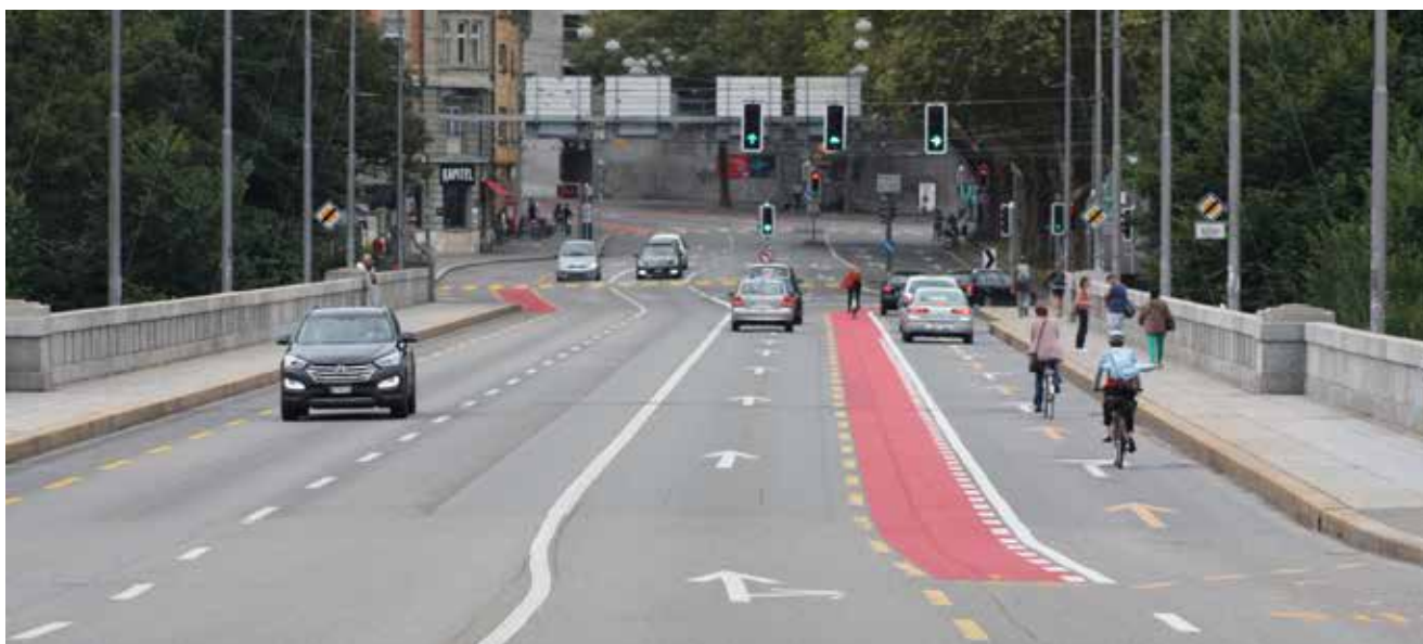
Abb. 1: Weder besonders steil, noch besonders eng - die Lorrainebrücke in Bern. Die Verkehrsführung auf der Brücke wird in mehreren Etappen geändert: ab 2019 folgt eine Verbreiterung der Radstreifen bis zu 3.00 m, bis 2025 eine Neuordnung des mittigen Radstreifens am rechten Fahrbahnrand.
