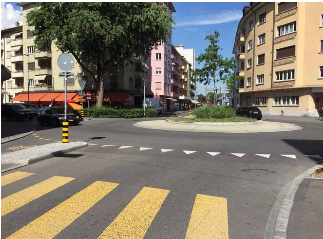
Abb. 5: Beispiel eines innerstädtischen Kleinkreisels mit deutlich abgesetztem und gut erkennbarem Innenring. (Biel/Bienne, Güterstrasse – Murtenstrasse)
