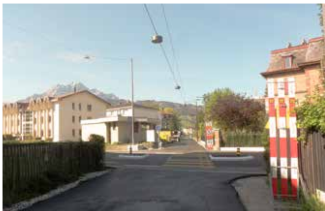
Abb. 1: Nicht vortrittsberechtigte Querung der Kantonsstrasse (vorher)
