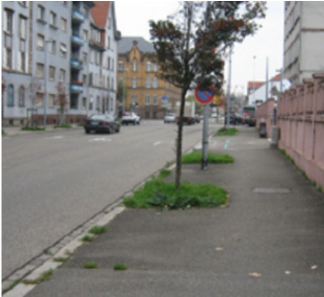
Abb. 4: Rue de Saales vor und nach der Sanierung
