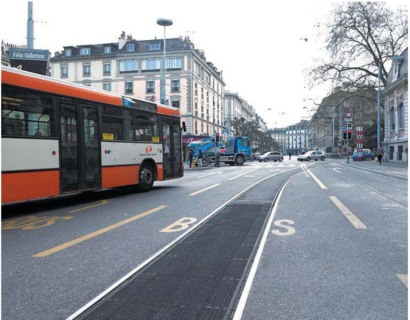
Einrichtung des Systems auf bestehender Tram-Strecke
