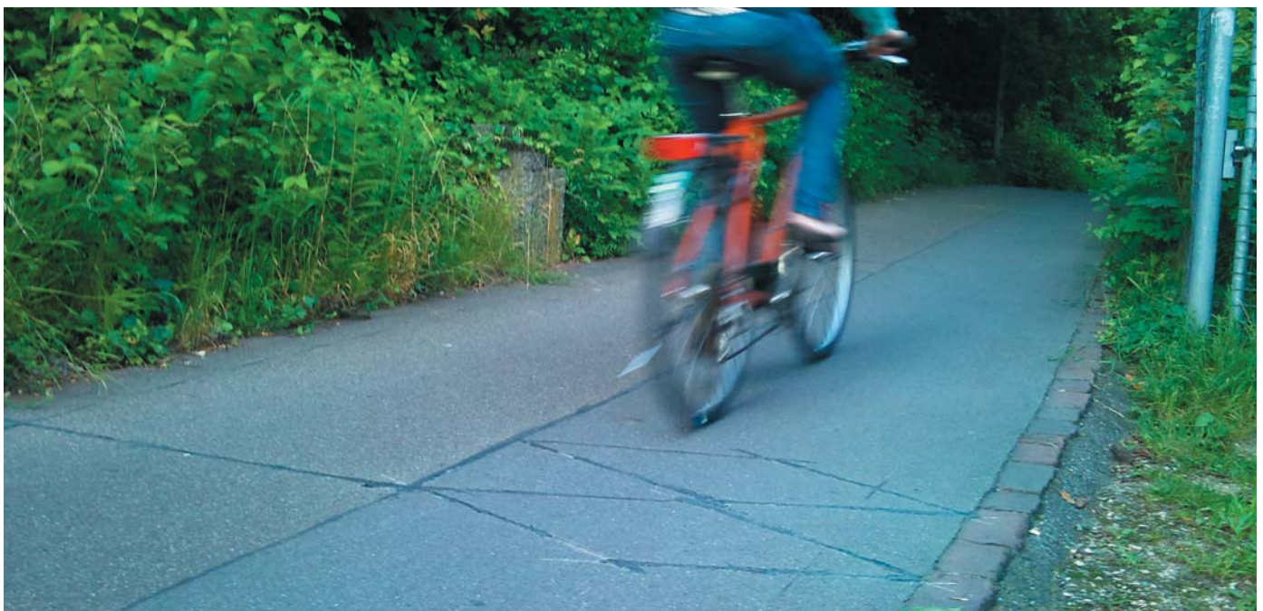
Im Strassenbelag eingelassener Induktionsschleife
