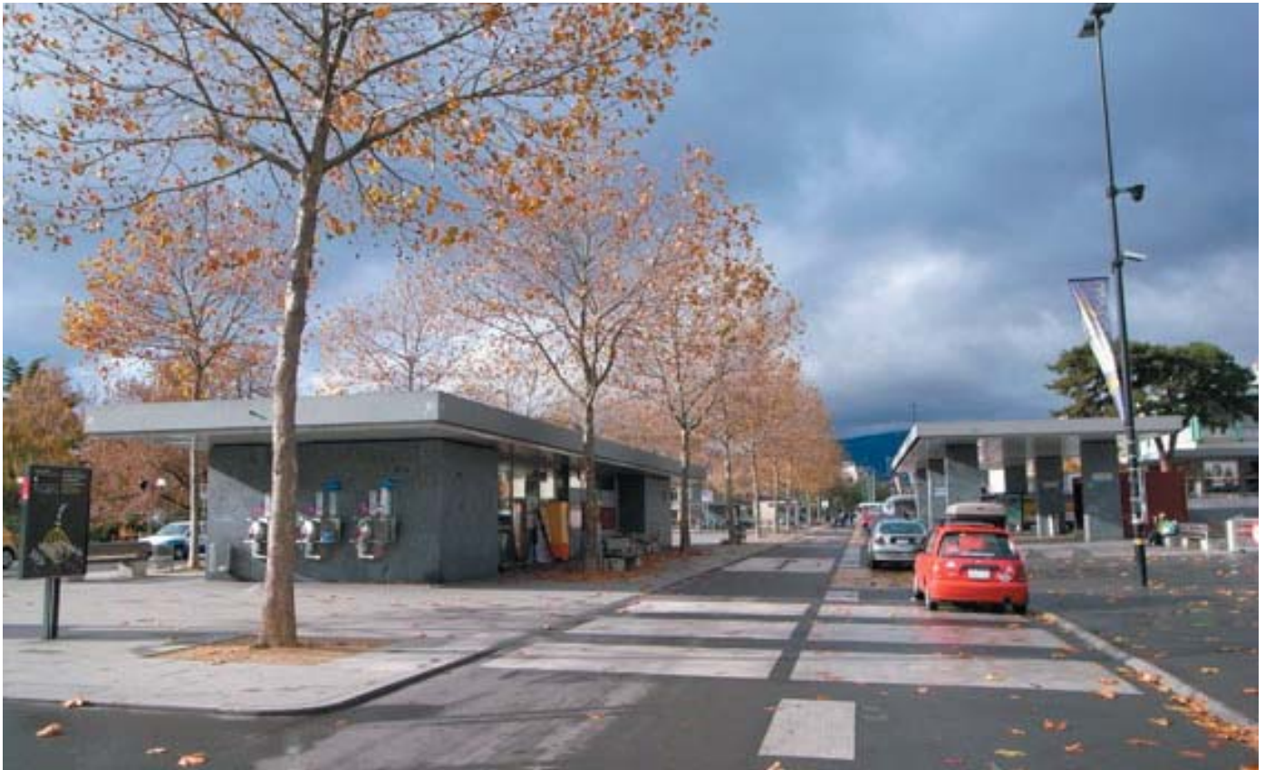
Neugestalteter Bahnhofplatz in Yverdon
