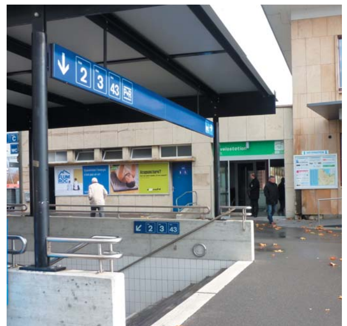
Eingang zur Velostation in Yverdon Entrée de la vélostation à Yverdon
