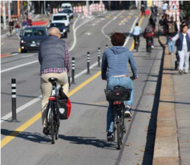
Abb. 3 Velohauptroute Wankdorf: Spurabbau MIV und breite Radstreifen
