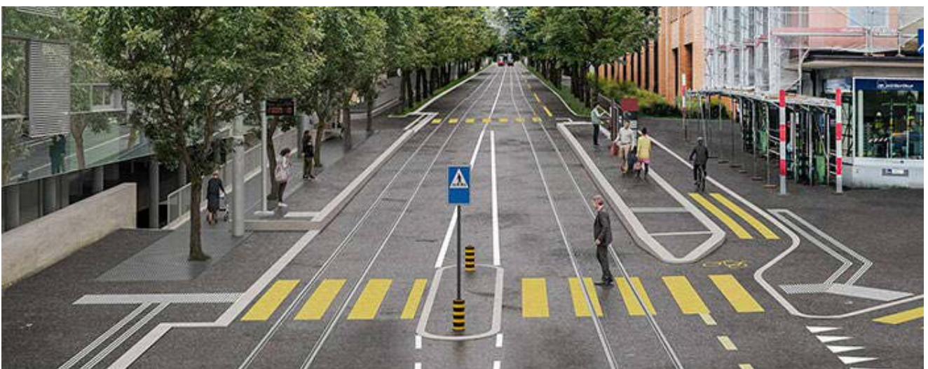
Abb. 5 Sanierung Monbijoustrasse (Werkleitungen und Tramgeleise): Eine Haltestellenumfahrung wird mitgeplant.
