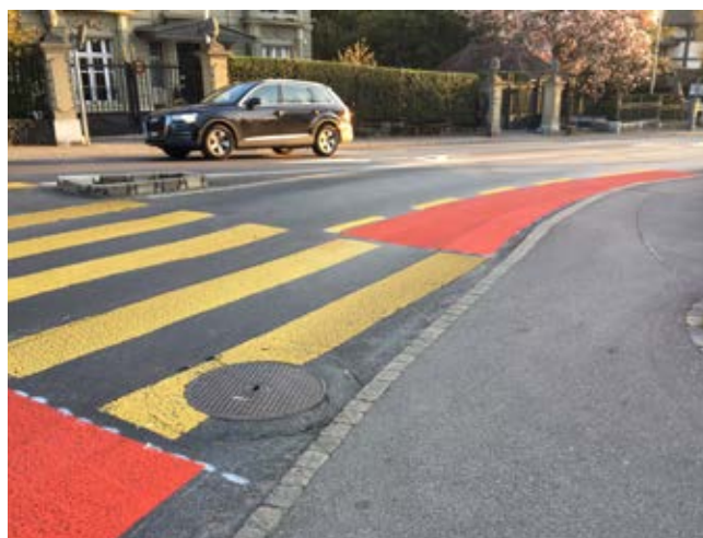
Abb. 2 Sofortmassnahme: Roteinfärbung Gefahrenstelle
