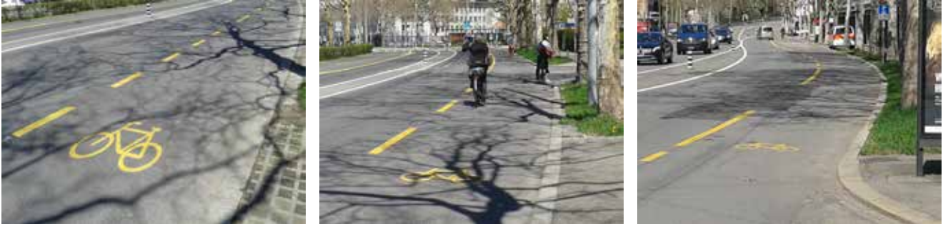
Bild 7a – 7c: Radstreifen mit Überbreite für sichere Überholmanöver (Nordring, Bern – Veloschnellroute Stadtzentrum – Wankdorf) (Quelle: Transitec)
