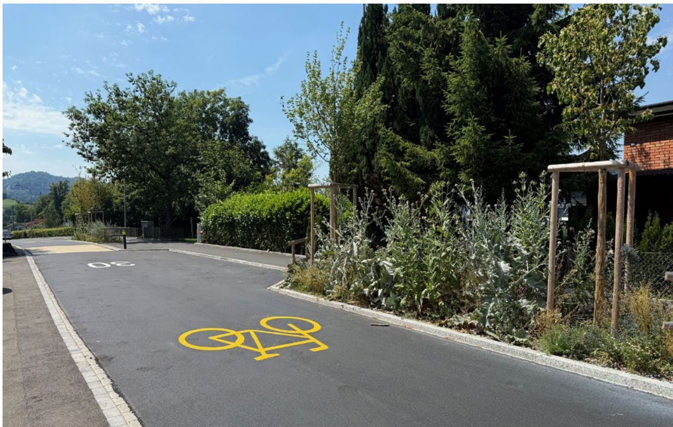
La Lehnstrasse réaménagée en rue cyclable (photo : Ville de Saint-Gall)
