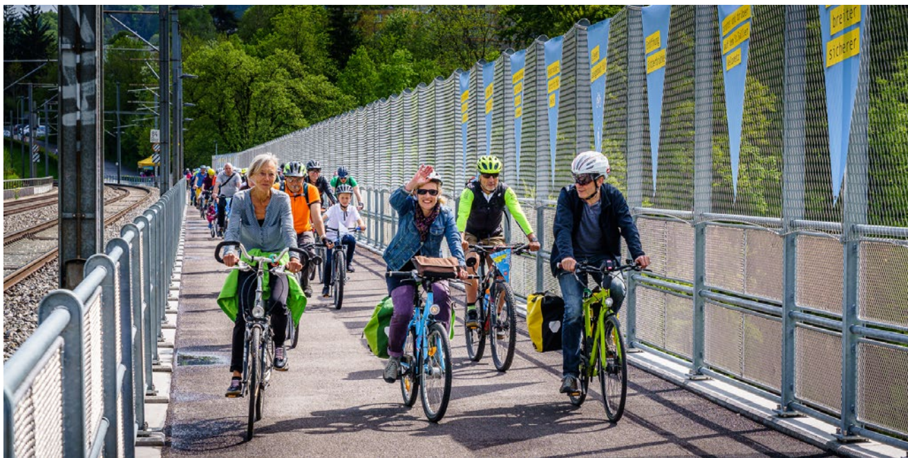
Velocorso lors de l'inauguration du Sitterbrücke des CFF (photo: Ville de Saint-Gall)
