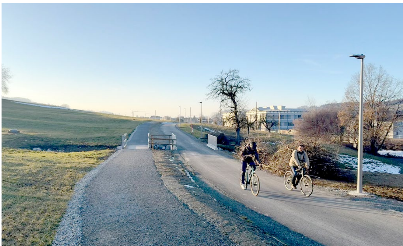
Le Neuhofweg en cours d'aménagement, avec des infrastructures piétonne et cyclable séparées (photo: Ville de Saint-Gall)
