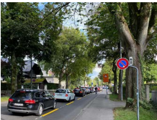
Fig. 1 Mesure urgente: nouvelle chaussée centrale banalisée et suppression d'une des voies du TIM au profit d'une bande cyclable
