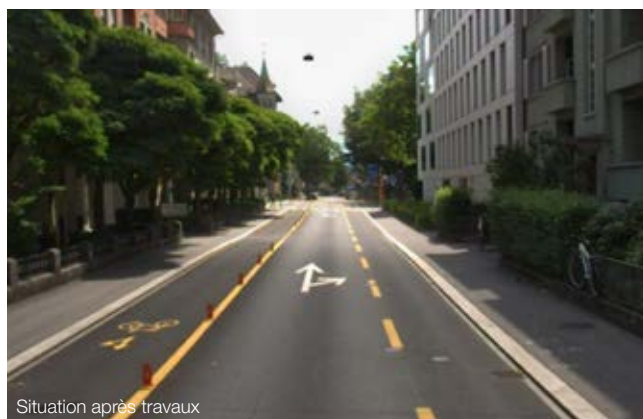
Fig. 3 Contresens cyclable créé aux dépens d'une des voies du TIM
