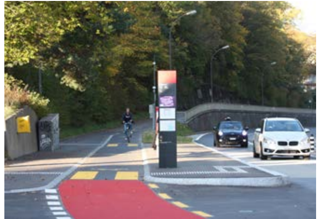
Fig. 3 Arrêt de la Dübystrasse, après les travaux
