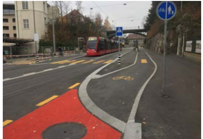
Fig. 5 Arrêt du Kursaal, après les travaux
