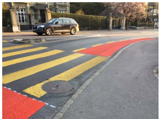
Fig. 2 Mesure urgente: revêtement coloré en rouge à un passage dangereux
