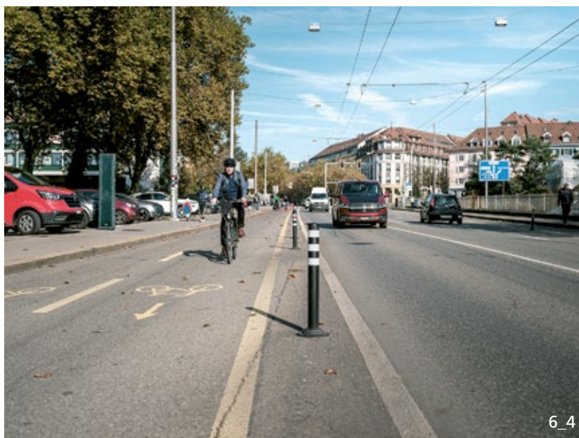
Bande cyclable protégée séparée des voies du trafic motorisé par des potelets (Lorrainebrücke, Berne).
