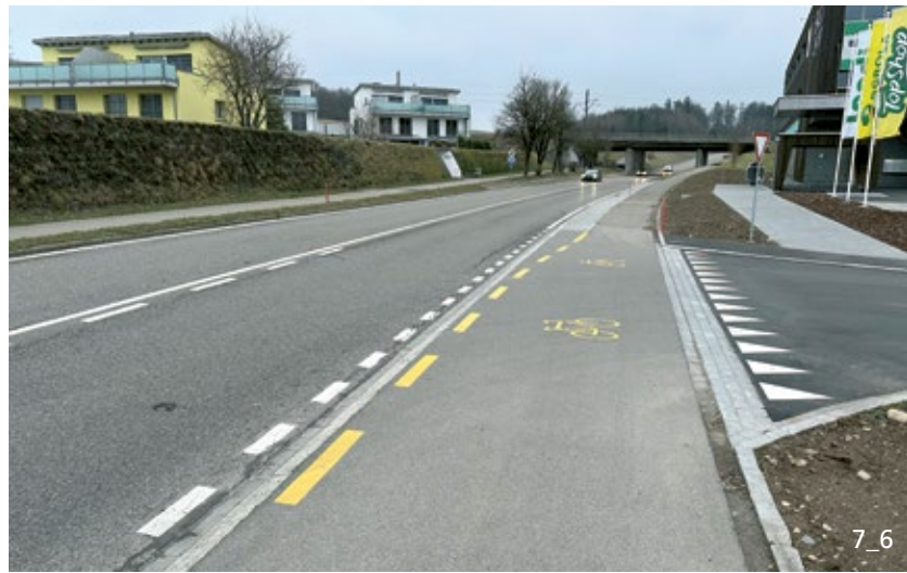
Franchissement cyclable prioritaire, adjacent à la chaussée, du débouché d'une route secondaire (Neue Winterthurerstrasse, Baltenswil).
