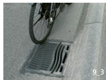
Grille d'égout cyclo-conforme (Ipsach).
