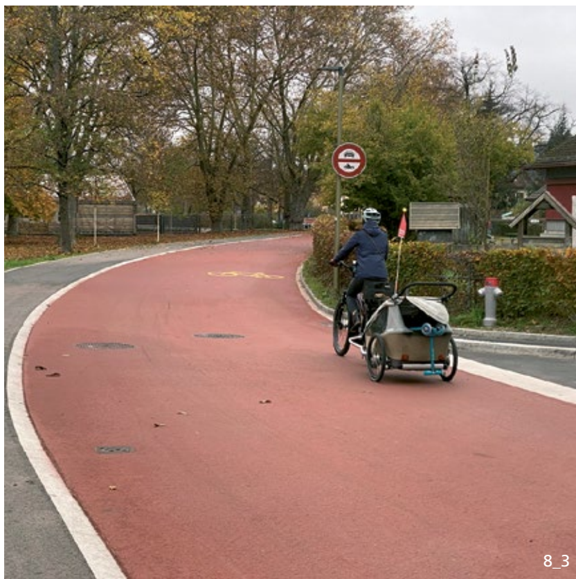
Exemple de revêtement rouge sur toute la surface d'une voie express cyclable (Winterthur).
