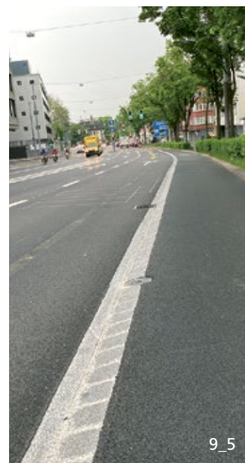
Bordure biaisée entre la chaussée et la piste cyclable unidirectionnelle (Murtenstrasse, Berne).
