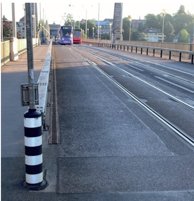
Abb 1: «Die Kornhausbrücke hat mir grosse Sorgen gemacht. Ich zuckte immer noch zusammen, wenn das Tram kommt.»
