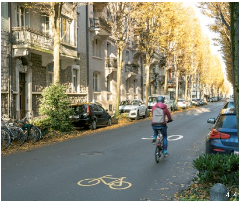
Velobahnen werden im städtischen Raum oft auf quaterverträglichen «Velostrassen» geführt. Führung und Orientierung erfolgen durch den abgestimmten Einsatz von Markierung und Signalisation (Bruchstrasse, Luzern).
