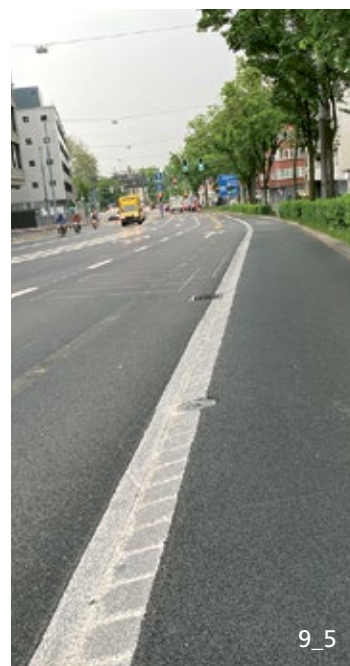
Schräger Randabschluss zwischen Fahrbahn und Einrichtungsradschwergang (Murtenstrasse, Bern)
