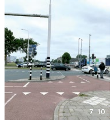
Kreuzung mit Lichtsignalanlage und abgesetztem Radweg (Amsterdam, Niederlande)
