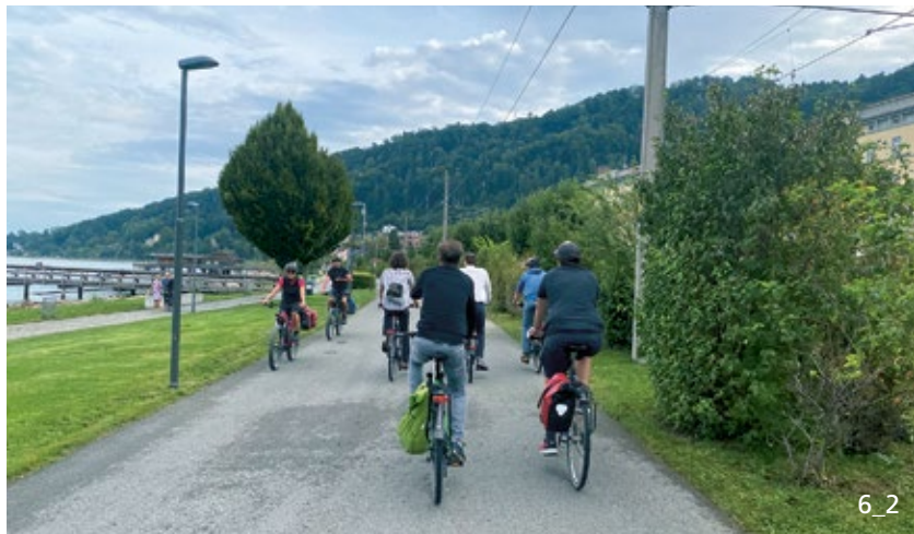
Breiter, frei geführter Zweirichtungsradweg (Bregenz, Österreich)
