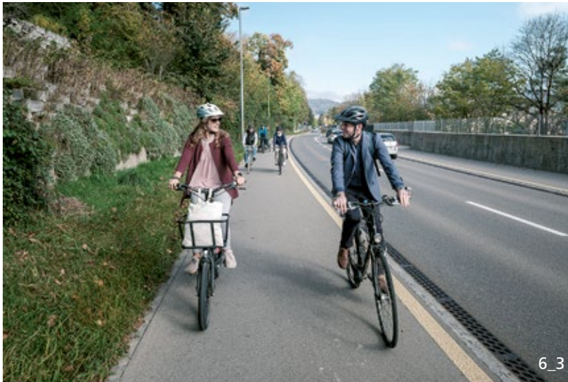
Breiter Einrichtungsrادweg (Tiefenastrasse, Bern)
