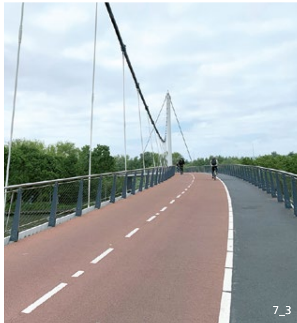
Brücke für den Fuss- und Veloverkehr mit Zweirichtungsradweg (Nesciobrug in Amsterdam, Niederlande)
