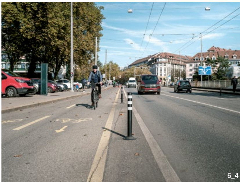
Geschützter Radstreifen durch Poller von der Fahrbahn des motorisierten Verkehrs getrennt (Lorrainebrücke, Bern)
