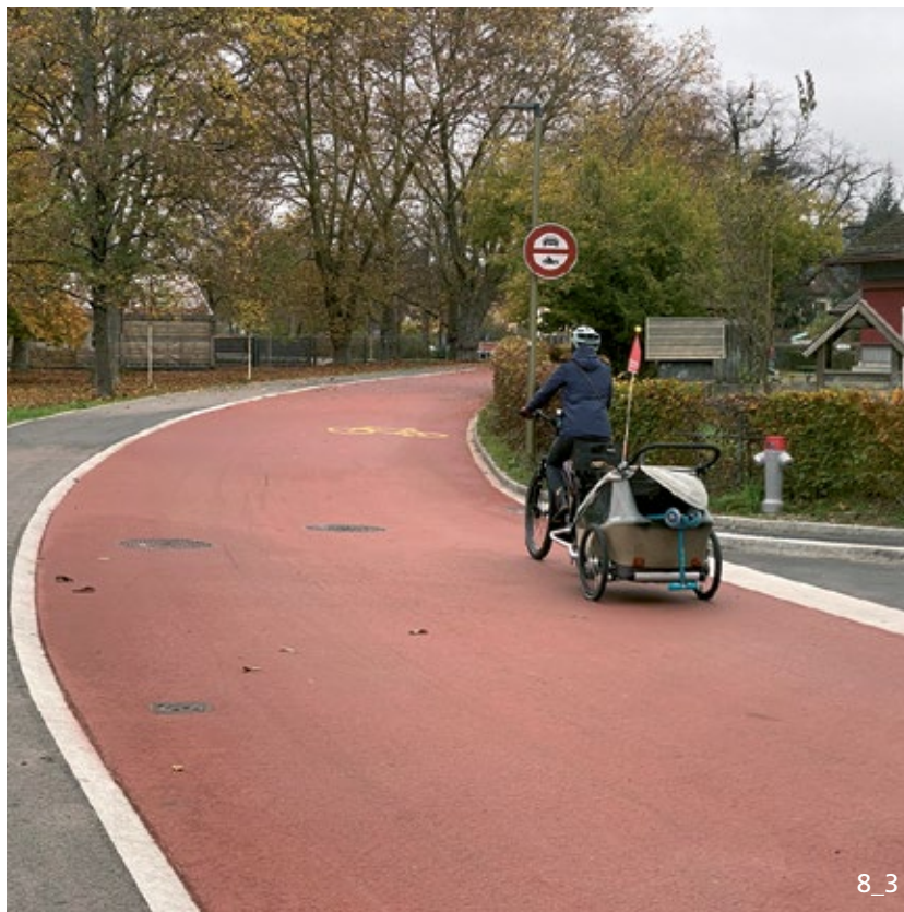
Beispiel für einen flächig rot eingefärbten Belag auf einer Velobahn (Winterthur)
