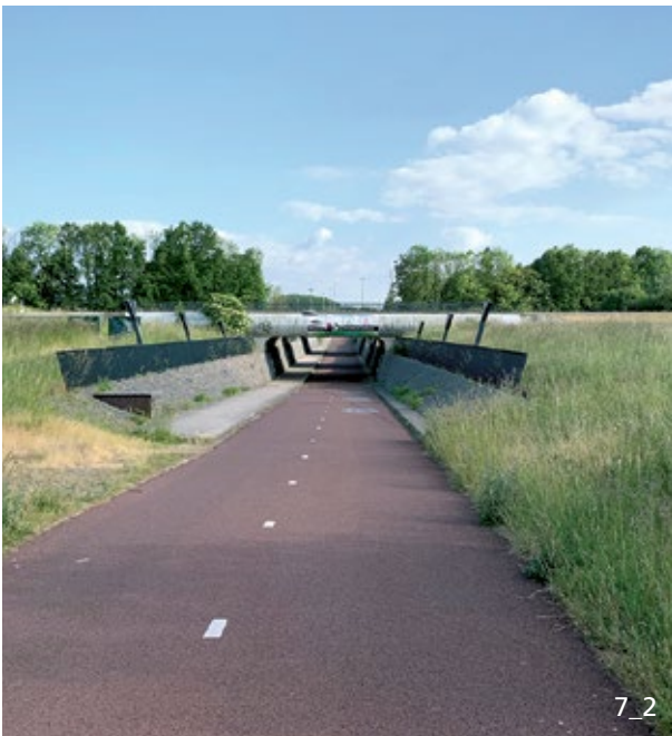
Unterführung mit einem Zweirichtungsradweg (RijnWaalpad, F325, in Ressen, Niederlande)
