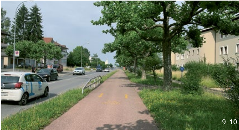
Zurückgeschnittene Grünbereiche und gepflegte Bäume entlang des Zweirichtungswegs (Rüeggisingerstrasse, Emmen)
