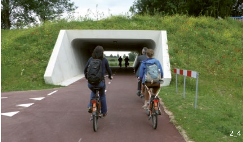
Velobahnen sind möglichst unterbrechungsfrei und direkt: Dieser Tunnel verkürzt die Strecke um 250 m und vermeidet auch eine Kreuzung mit einer stark befahrenen Strasse (RijnWaalpad, Niederlande).
