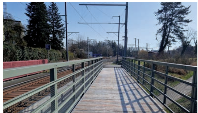
La passerelle de l'Emme est déjà en service ; la commune de Biberist a pu soumettre son élargissement dans le projet d'agglomération de la 2 e génération comme mesure de remplacement (photo : Linus Heini)
