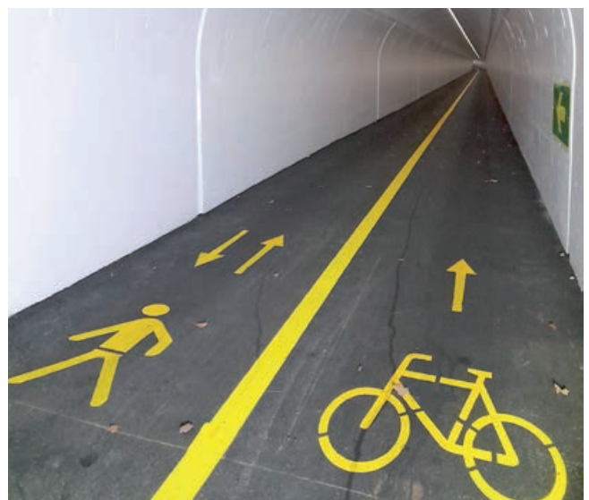
Le tunnel a déjà été présenté comme infrastructure du mois sur le site web roadmapvelo.ch : roadmapvelo.ch/fr/infrastructure-des-monats/galerie-de-securite-la-clusette/ (photo : Service des ponts et chaussées, Neuchâtel)
