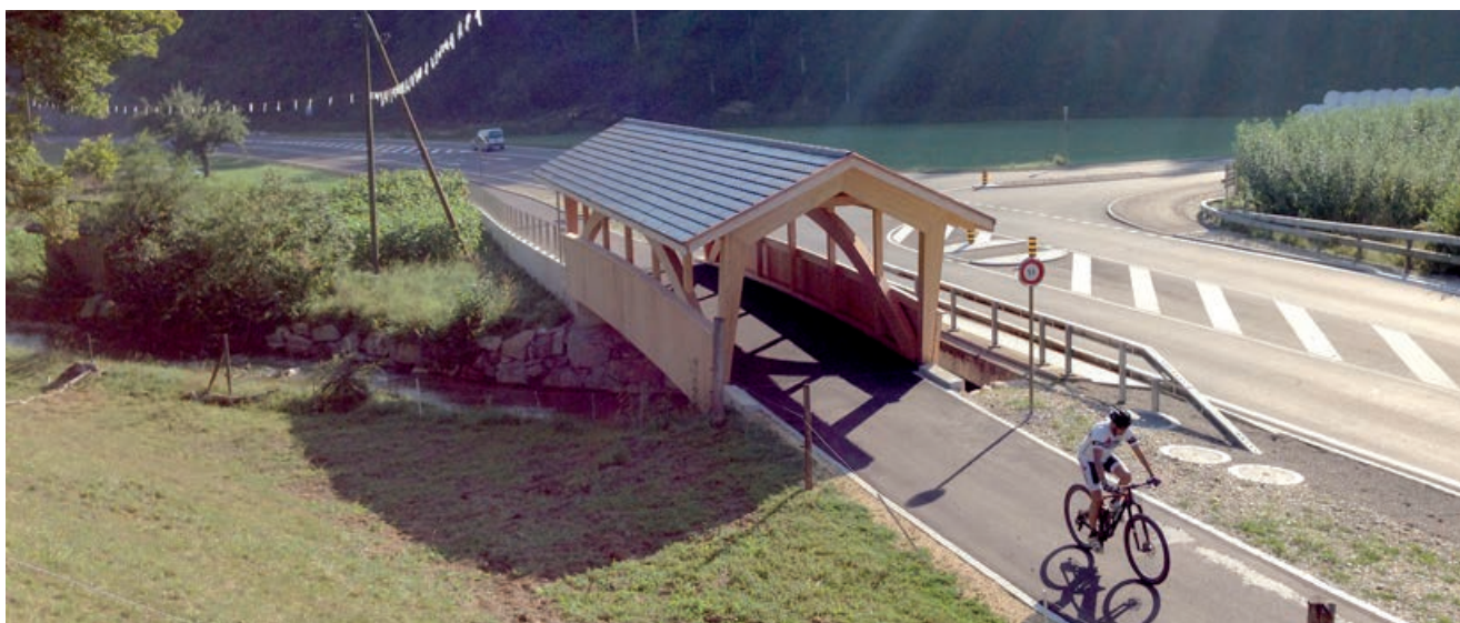
Entre Bubendorf et Ziefen : même les voies cyclables nécessitent parfois des ouvrages d'art complexes (et bien visibles) (photo : Armin Schmauss)
