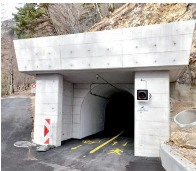
Vous trouvez l'endroit de la galerie de sécurité du tunnel de la Clusette au Val-de-Travers sur le géoportail cantonal : https://sitn.ne.ch/s/lkhH7 (photo : Service des ponts et chaussées, Neuchâtel)
