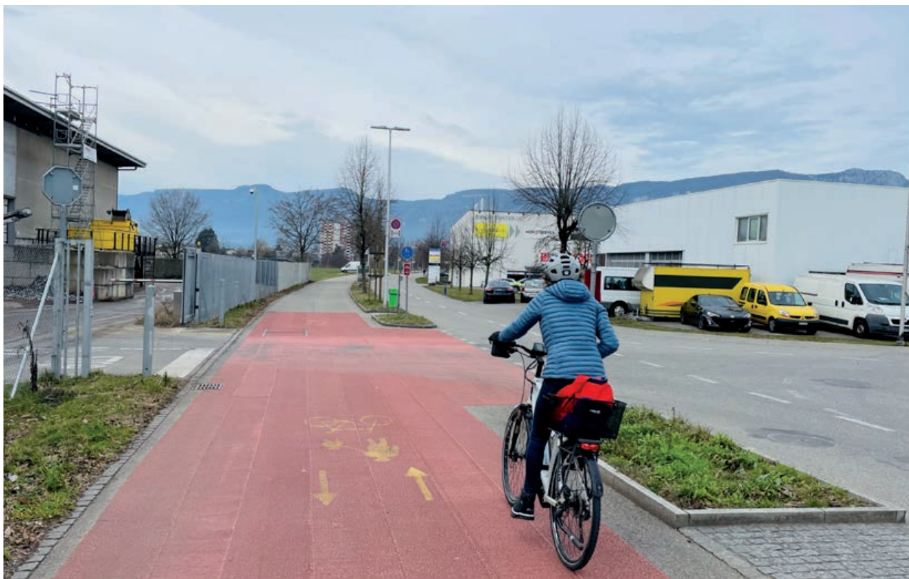
En périphérie de l'agglomération de Soleure, un chemin piéton/piste cyclable bidirectionnelle séparé du trafic automobile et du trafic lourd a été aménagé. Sa largeur est suffisante pour permettre le croisement et le dépassement de vélos plus lents (photo : Laurent Dutheil)
