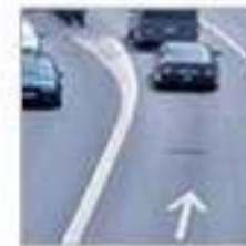
Schäden früherer Entwicklungen reparieren
