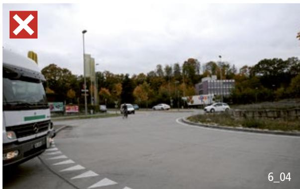
Un anello di circolazione troppo largo con un'isola centrale eccessivamente piccola e un anello centrale non abbastanza sopraelevato sono inadatti alle biciclette.
