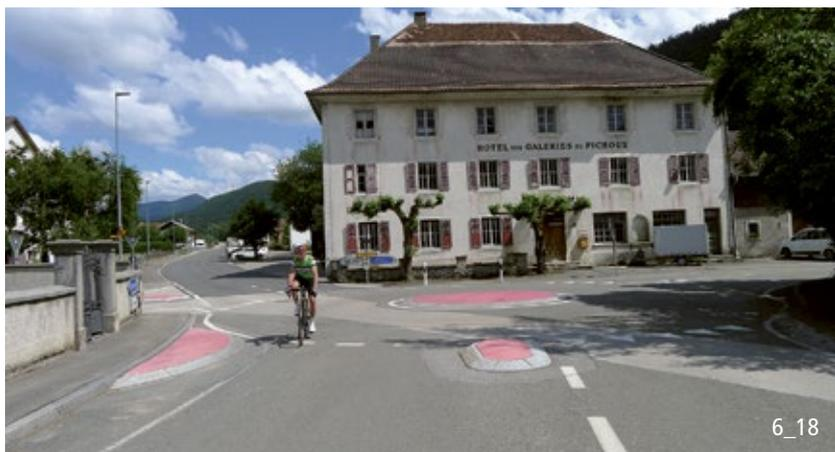
Minirotorie  $d = 15$  m, anello di circolazione escluso anello centrale  $5,25$  m, isola centrale pavimentata  $d = 4,5$  m, isola centrale sormontabile ma rialzata (altezza al bordo =  $7,5$  cm, al centro = ca.  $12$  cm); isole direzionali rialzate e messe in evidenza con apposita colorazione.
