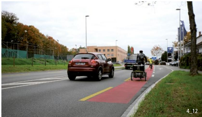
Corsia di preselezione per la svolta a destra nelle intersezioni non semaforizzate: da utilizzare solo negli incroci senza confluenze (cfr. fig. 420).
