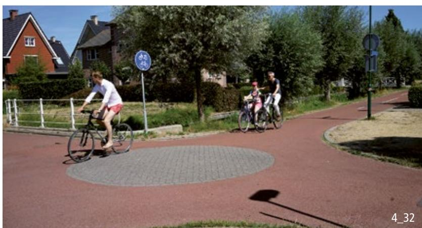
Incrocio fra piste ciclabili con precedenza a destra. L'isola centrale sormontabile incrementa la visibilità dell'intersezione.
