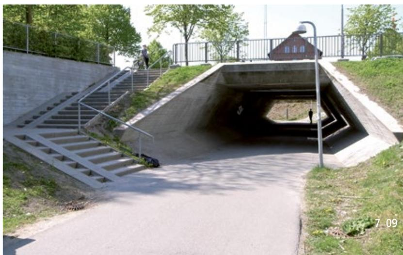
I sottopassaggi romboidali danno un senso di ampiezza e permettono di sfruttare al meglio tutta la larghezza del manufatto (Danimarca).
