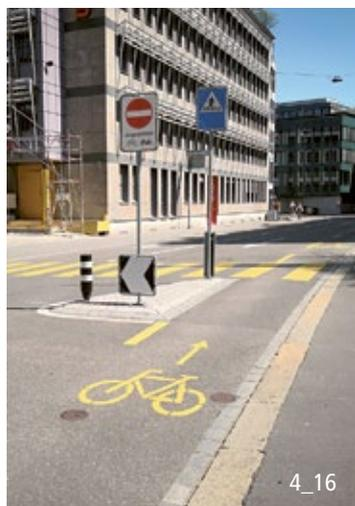
L'isola di separazione segnala l'accesso a un senso unico eccetto bici.
