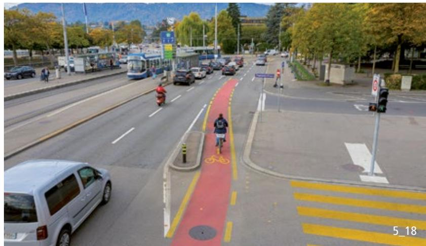
Corsia di preselezione per la svolta a destra. L'elemento strutturale impedisce ai veicoli a motore di superare la striscia troppo presto.
