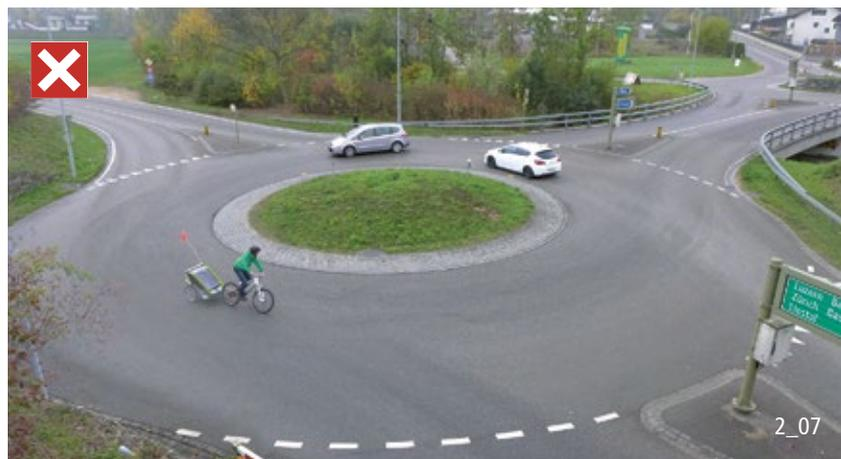
Rotatoria pericolosa a causa dell'errata geometria: l'anello di circolazione troppo ampio e la traiettoria diretta comportano elevate velocità del TMP.
