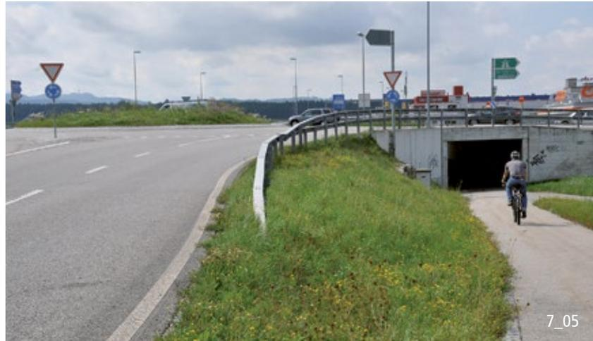
Il sottopassaggio permette ai ciclisti di evitare la rotonda a due corsie non cicloconforme.
