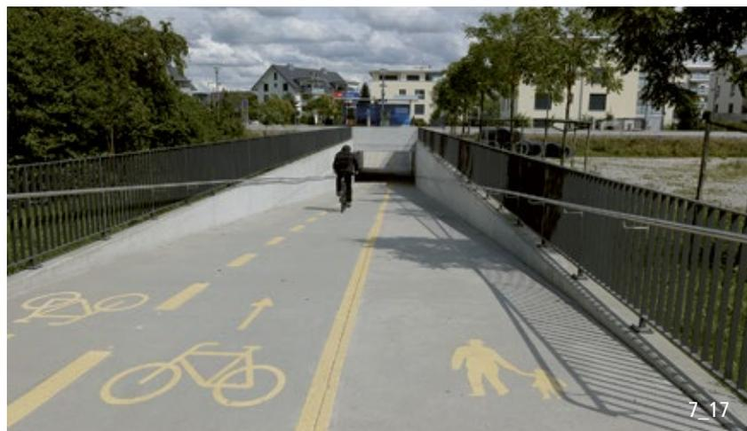
Sottopassaggio rettilineo e quindi visibile dotato di rampe comode.
