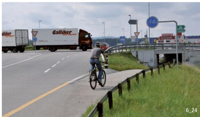
I ciclisti aggirano la rotonda a due corsie mediante un attraversamento su un altro livello.
