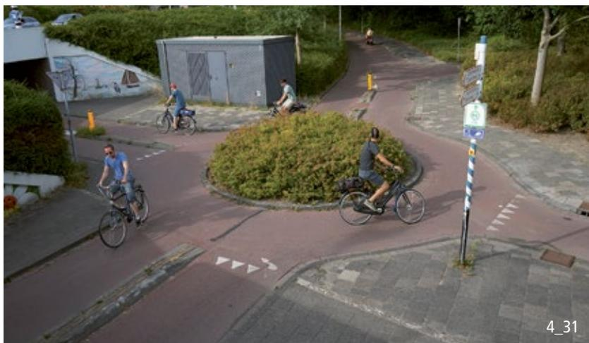
Incrocio fra piste ciclabili con rotonda, diametro esterno = 10 m, diametro isola = 5 m.
