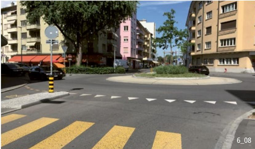
Isola centrale situata sull'asse stradale, anello centrale ben visibile e sormontabile in taluni casi.
