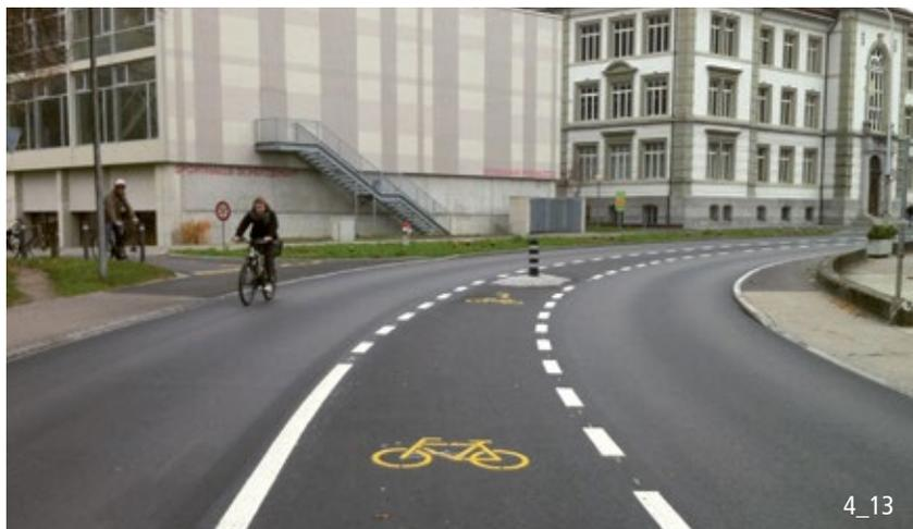
Svolta a sinistra in una curva destrorsa con corsia di preselezione.
