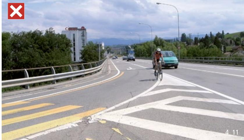
Da evitare assolutamente: corsia riservata a chi procede dritto raggiungibile solo con una manovra di svolta a sinistra o percorrendo un lungo tratto fra due corsie.
