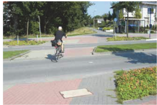
Abbildung 42: Beispiel einer vortrittsbelasteten Veloquerung in Deutschland
