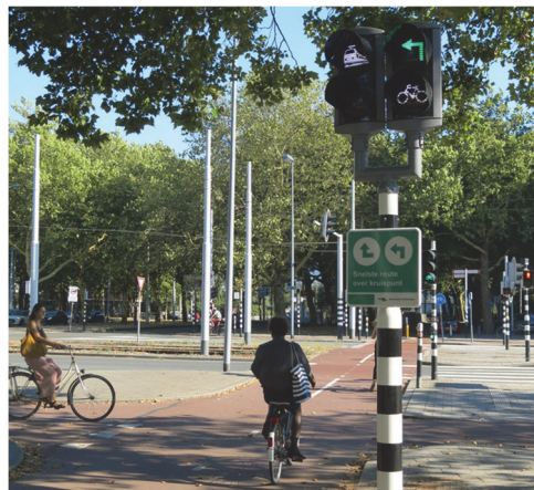
Abbildung 47: Mit zusätzlichem Signal wird für die Linksabbiegebeziehung die schnellste Kombination der Grünphase angezeigt
