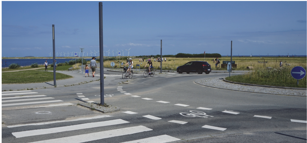
Abbildung 34: Radstreifen auf der Kreiselfahrbahn in Dänemark. Als Umsetzung für die Schweiz nicht empfohlen
