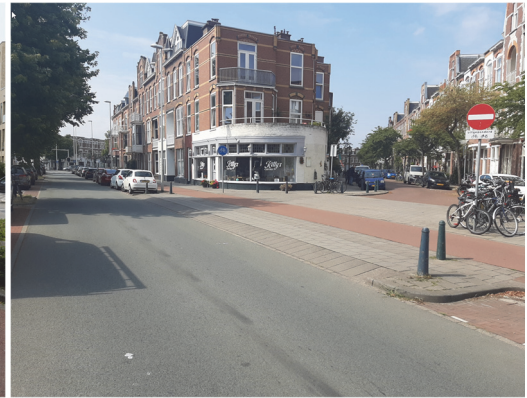
Abbildung 15: Vortrittsberechtigter Veloführung über Einmündung in den Niederlanden, als Trottoirüberfahrt 2 – 5 m zurückversetzt
