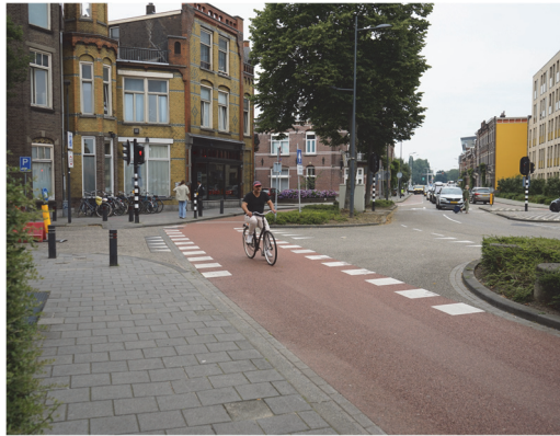
Abbildung 14: Vortrittsberechtigter Veloführung über Einmündung in den Niederlanden, als Radweg 5 m zurückversetzt
