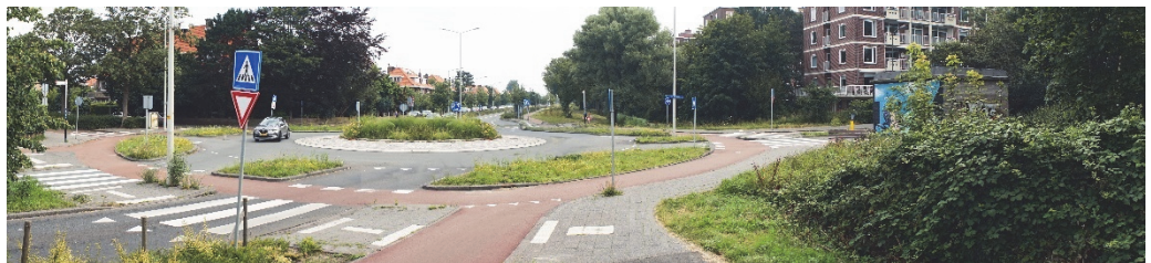
Abbildung 27: Kreisel im Einrichtungsverkehr, Kreiseldurchmesser Fahrbahn 26 m
