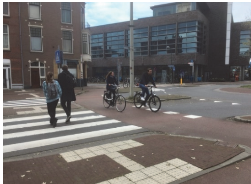
Abbildung 25: Kreisel im Einrichtungsverkehr in dicht bebautem Gebiet
