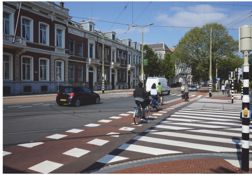
Abbildung 49: Bei engen Verhältnissen Anordnung der Velofurt ohne Rückversatz
