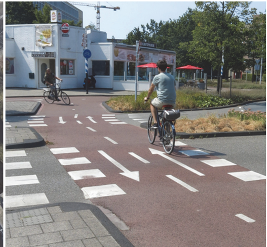
Abbildung 24: Kreisel mit umlaufendem Zweirichtungsradweg
