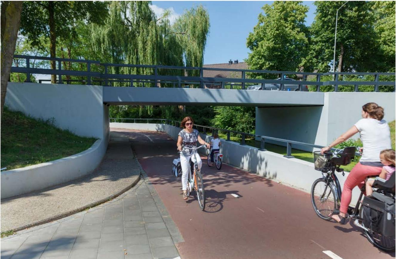
Abb. 5: Unterführungen ermöglichen eine unterbrechungsfreie, kreuzungslose und komfortable Fahrt auf den Doorfietsroutes. (Foto: Martien van Duren, Haskoning)
