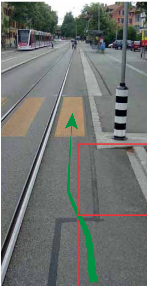
Fugenlage akzeptabel an der Haltestelle Steigerhubel
