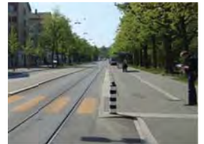
Haltestelle Schlossmatte: Abgrenzung Haltestellenbereich durch Randsteine
