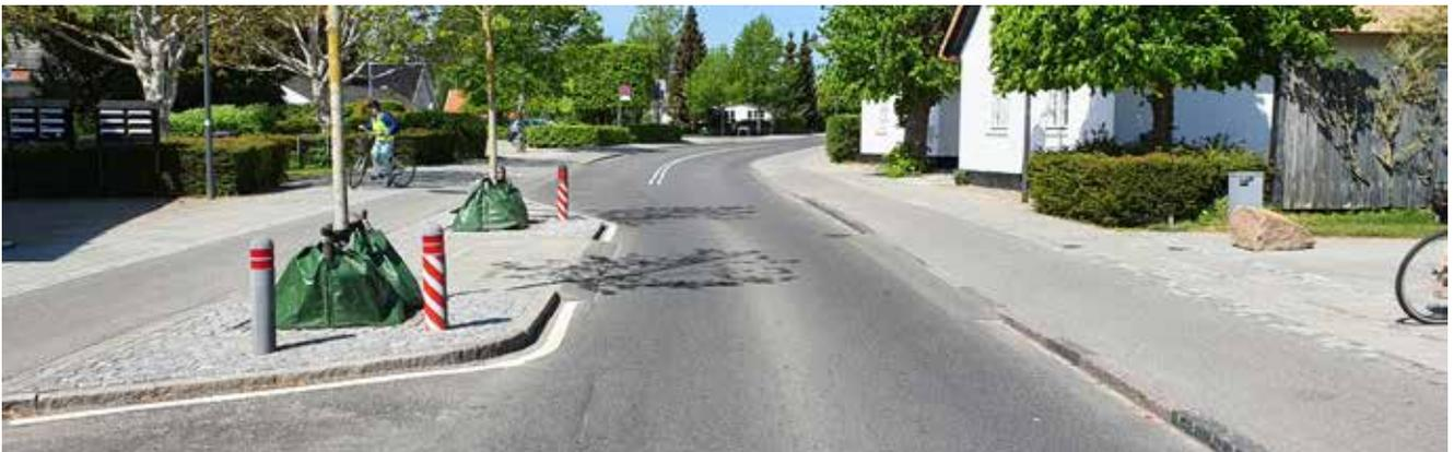
Fig. 7 : Exemples de rétrécissements latéraux de la chaussée et de pistes cyclables unidirectionnelles des deux côtés (dans la commune de Furesø)
