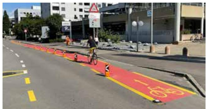
Fig. 5: Bande cyclable sur la Baslerstrasse avec ligne de protection et balises de sécurité
