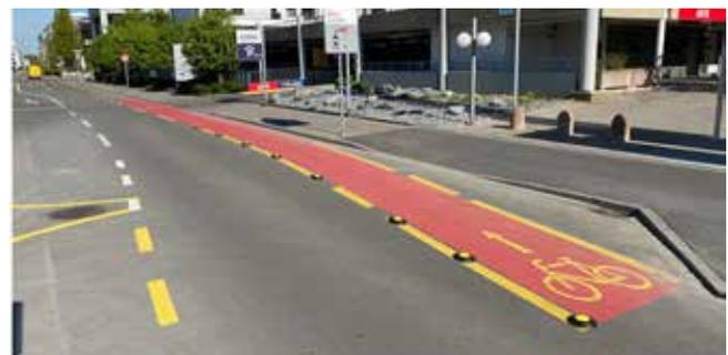
Fig. 4: Bande cyclable sur la Baslerstrasse avec ligne de protection et plots routiers
