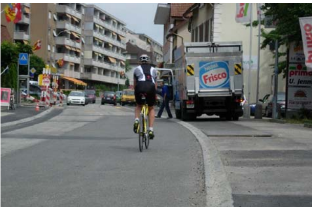
Photo 10: Pieterlen: le tronçon de chaussée réduite durant les travaux, vue en direction de Soleure.
