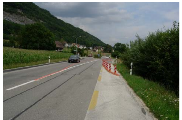
Photo 7: Pieterlen: aménagement de la porte d'entrée, vue en direction de Soleure.
