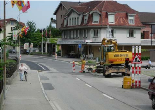
Bild 8: Pieterlen: Beginn der 325 m langen Rückbaustrecke im Ortskern, Blick Solothurn.
