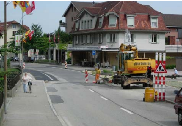
Photo 8: Pieterlen: début du tronçon de 325 m sur lequel la largeur de la chaussée est réduite, vue en direction de Soleure.
