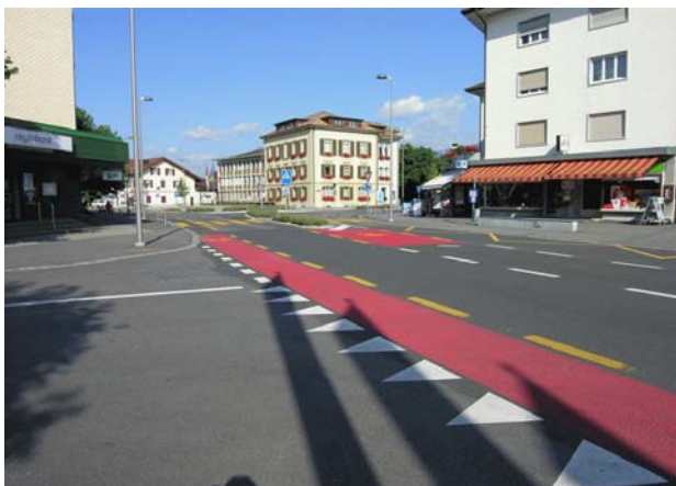
Bild 17: Zuchwil, Umbau Hauptstrasse im Zentrum
