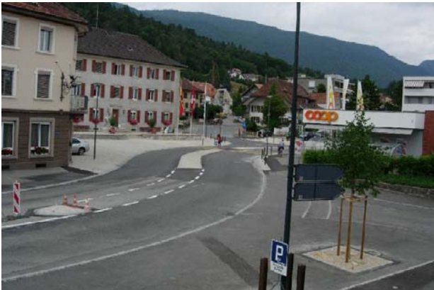
Photo 13: Lengnau, raccordement ouest de la zone de rencontre, vue en direction de Soleure.
