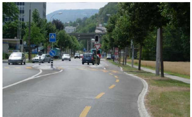
Bild 3: Knoten Johann-Renferstrasse, Blickrichtung Biel.
