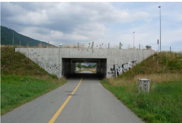
Photo 6: Passage cyclable souterrain sous la jonction de l'A5, vue en direction de Soleure.
