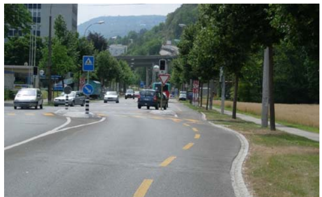
Photo 3: Carrefour Johann-Renferstrasse, vue en direction de Bienne.
