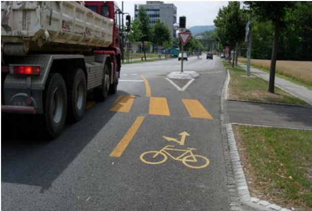
Bild 4: Knoten Johann-Renferstrasse, Blickrichtung Biel.
