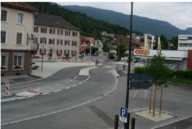
Bild 13: Lengnau, Anschluss West der Begegnungszone, Blickrichtung Solothurn.
