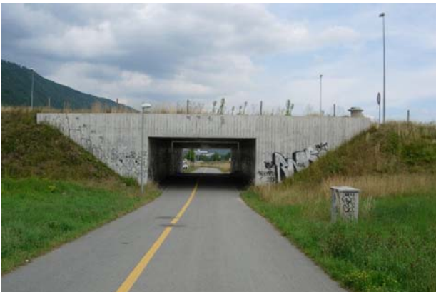
Bild 6: Radwegunterführung Anschlussbauwerk N5, Blickrichtung Solothurn.
