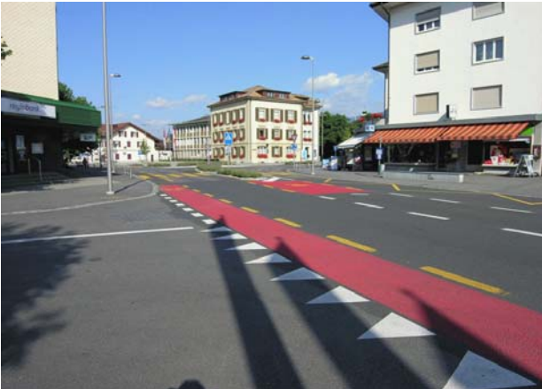
Photo 17: Zuchwil, transformation de la route principale en centre
