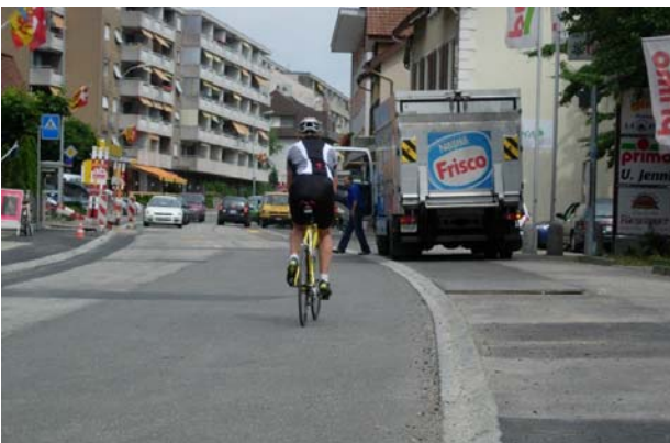
Bild 10: Pieterlen: Rückbaustrecke während der Bauphase, Blickrichtung Solothurn.
