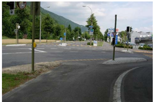
Photo 2: Carrefour Johann-Renferstrasse, vue en direction de Soleure.
