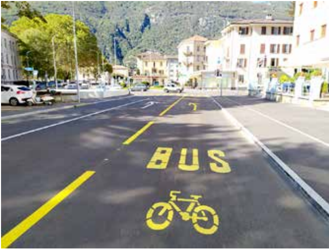
Abb. 2 Neue gemeinsame Bus- und Velospur entlang der Vicolo Santa Marta
