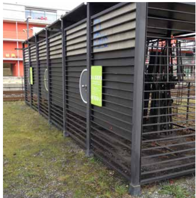
Abschliessbare Velostation Tramendstation Seebach
