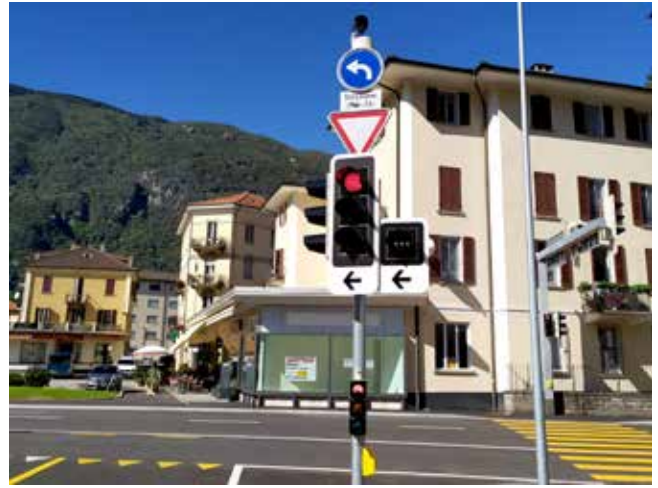
Lichtsignalanlage mit erhöht positioniertem Wärmebildsensor.
