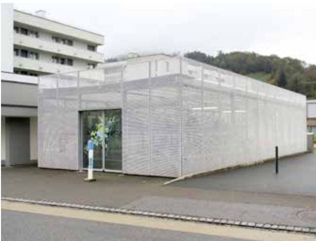
Abschliessbare Veloparkierung Heerbrugg SG
