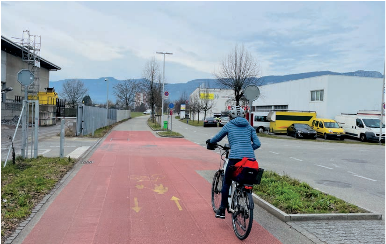
In der Agglomerationsperipherie von Solothurn wurde ein vom Auto- und Schwerverkehr abgetrennter Fuss- und Zweirichtungsradweg angelegt. Er ist genügend breit, um das Kreuzen und das Überholen langsamerer Velos zu ermöglichen. (Foto: Laurent Duthell)
