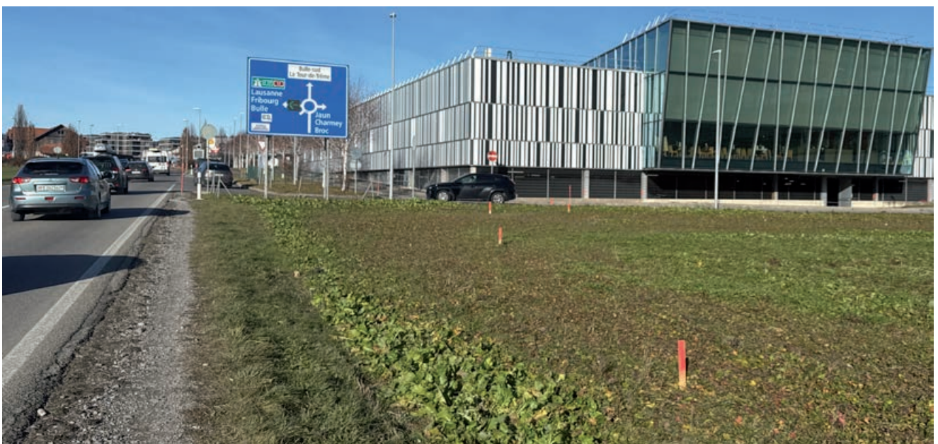
Absteckung einer geplanten Mischverkehrsfläche für den Fuss- und Veloverkehr in La Tour-de-Trême (Quelle: TBA, P. Rime)
