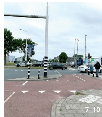
Incrocio semaforizzato con pista ciclabile arretrata (Amsterdam, Paesi bassi)
