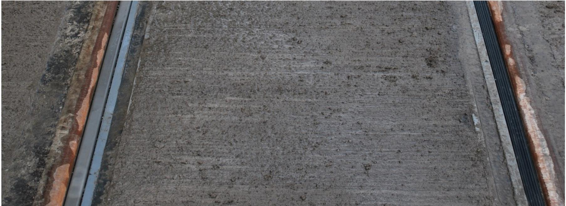
Deux systèmes différents sont installés, très positifs pour les vélos, le caoutchouc s'use trop vite, s'est déplacé à l'intérieur du rail
