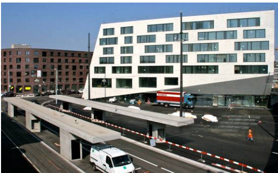
Vogesenplatz und Volta Zentrum kurz vor Bauabschluss
