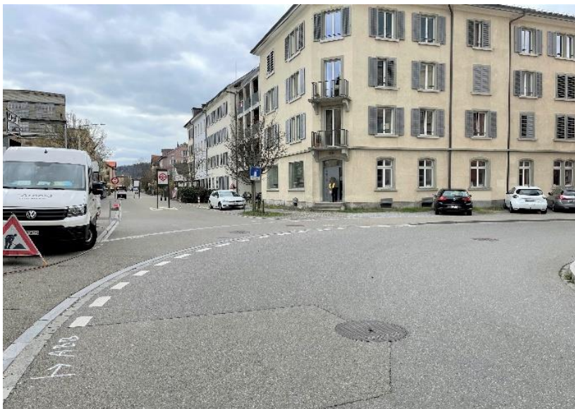
Abbildung vorher: Trottoirführung steht der Veloroute im Weg
