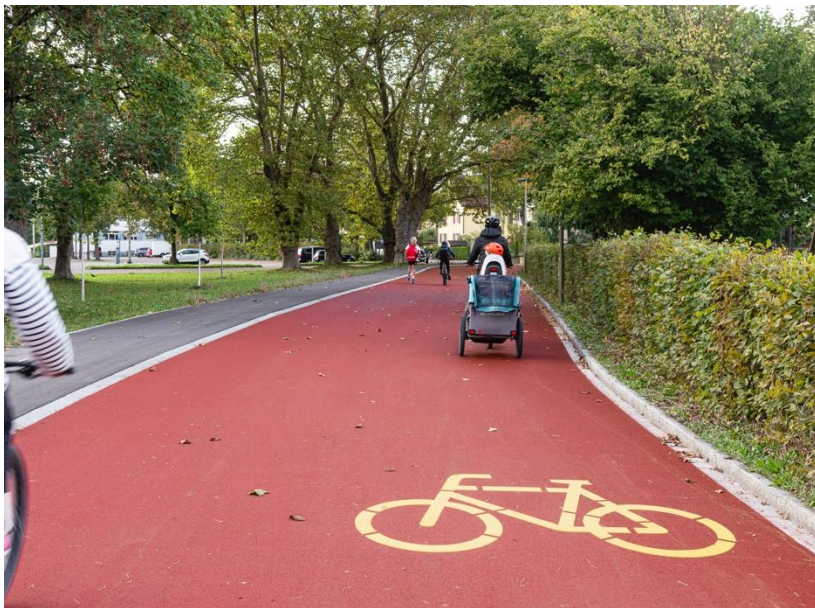
Rote flächige Belagseinfärbung
