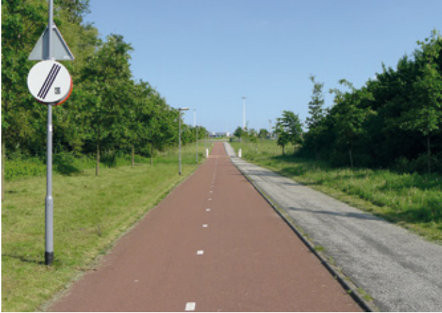
Velobahn ist auf Eigentrasssee geführt (NL).
