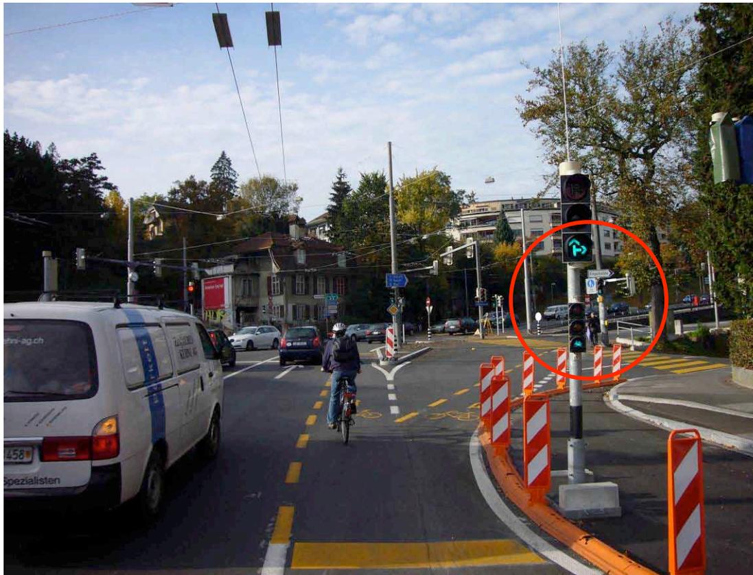
Dem Veloverkehr steht ein eigener Fahrstreifen zur Verfügung. Trotz der getrennten Führung haben sowohl der geradeaus fahrende, wie auch der rechtsabbiegende Verkehr gleichzeitig grün.
