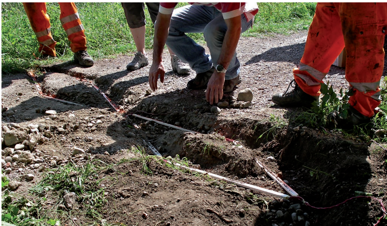
Fig. 3 : Pose d'un compteur piétons/cyclistes au bord de la Limmat à Zurich en 2010 (Photo : Daniel Sauter)
