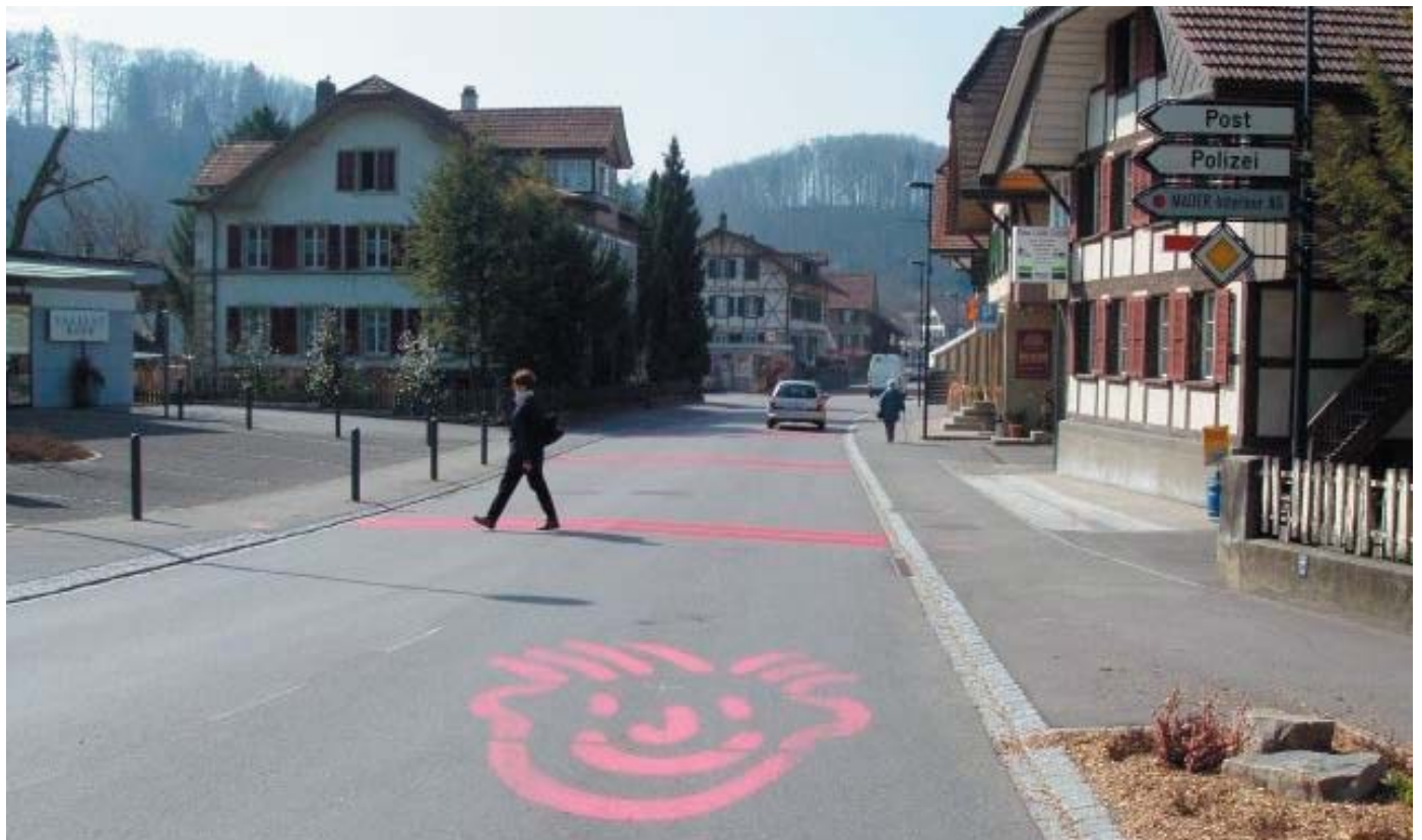
Dorfstrasse Neueneegg: Flächiges Queren auf der Kantonsstrasse
