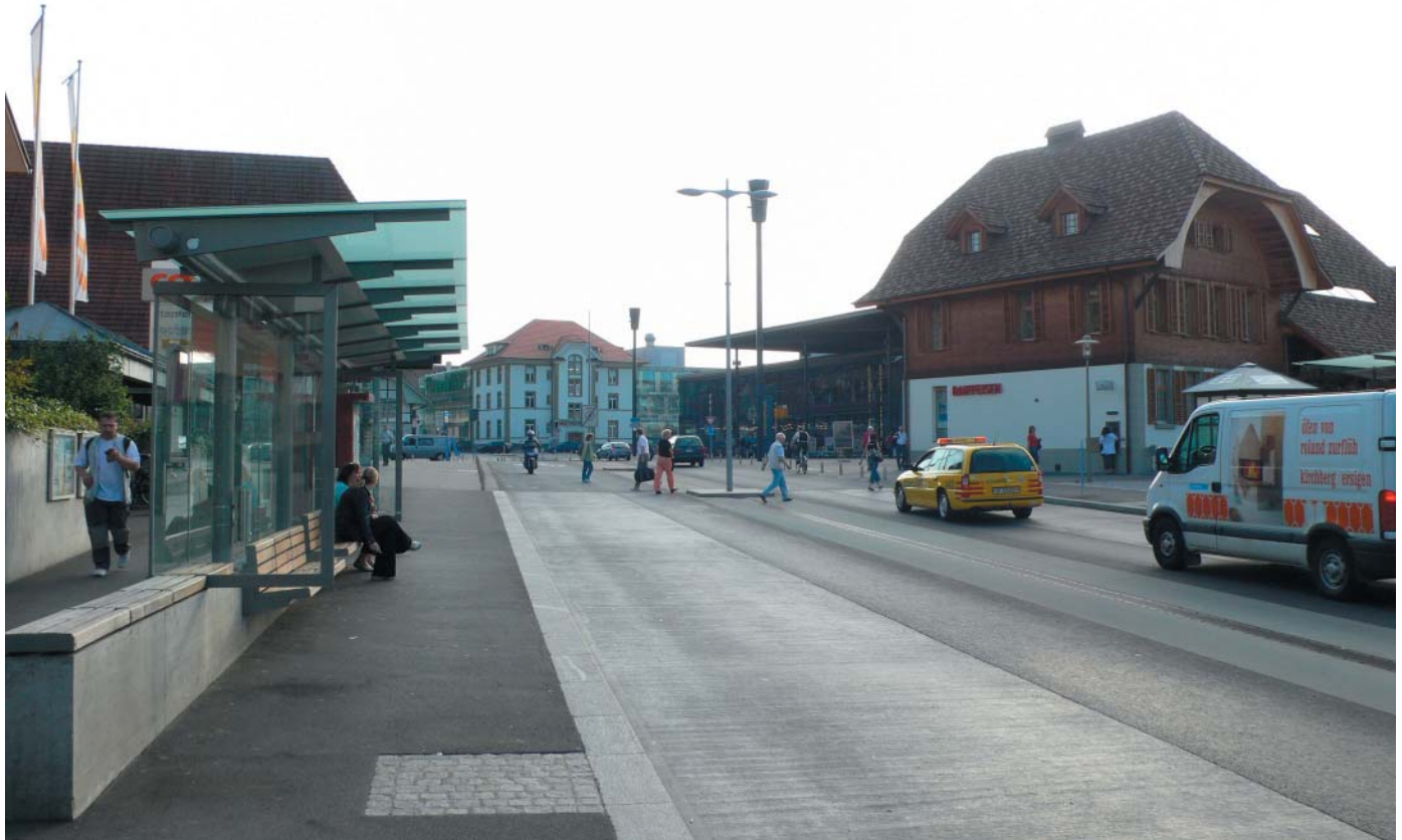
Kantonsstrasse im Zentrum von Köniz
