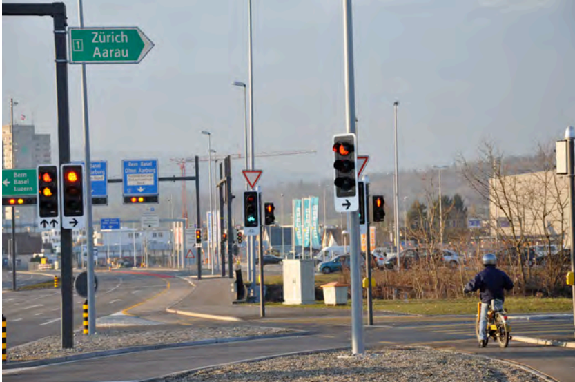
Getrennte Führung und mit Ampel gesicherte Querung der Autobahneinfahrt.
