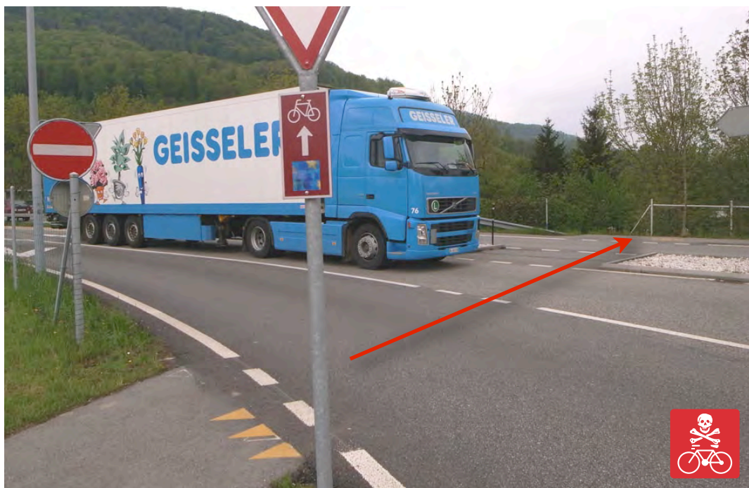
Radweg führt über zweistreifige (!) Ausfahrt und über einstreifige Einfahrt zu HLS.
