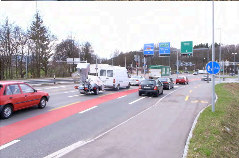
Durchgezogener und deutlich sichtbarer Radstreifen für sichere, Zusatzangebot mit Radweg für ungeübte Velofahrende. Wichtig: Fahrstreifen Richtung HLS im Additionsprinzip.
