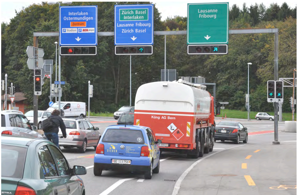
Anschlüsse an HLS stellen besonders hohe Anforderungen an Planung und Bau.
