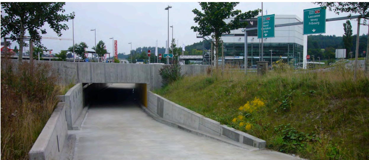
Kreuzungsfreie Führung des Veloverkehrs mit Unterführung.
