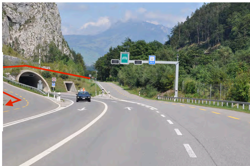
Nahtloser Übergang einer HLS in eine Mischverkehrsstrasse ohne Fahrbahnquerung (gute Lösung). Einfahrt (links): kreuzungsfreie Führung des Veloverkehrs; Radstreifen wird im Additionsprinzip an den MIV-Streifen angefügt (nicht im Bild). Ausfahrt (rechts): klare Führung des Veloverkehrs mit Radstreifen, damit Velofahrende nicht auf die HLS gelangen.
