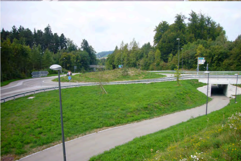
Getrennte Führung mit kreuzungsfreier Querung des Autobahnanschlusses.
