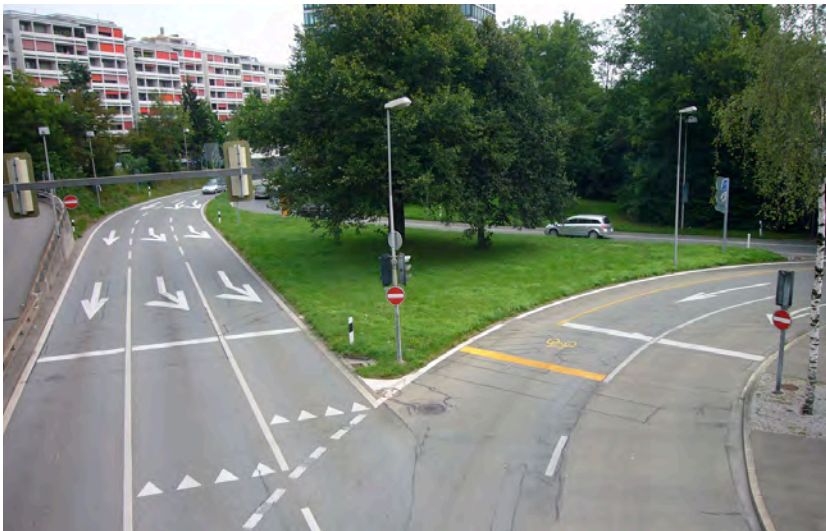
Ausfahrt HLS mit Lichtsignalsteuerung und Vortrittsentzug.
