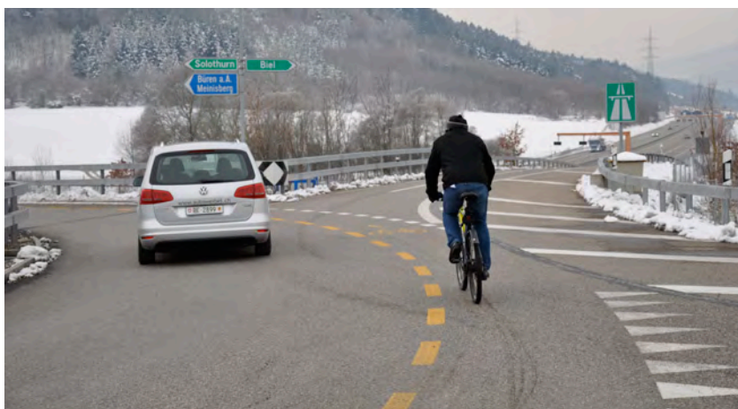
Grosskreisel an Autobahnanschluss mit Veloverkehrsführung im Mischverkehr.
