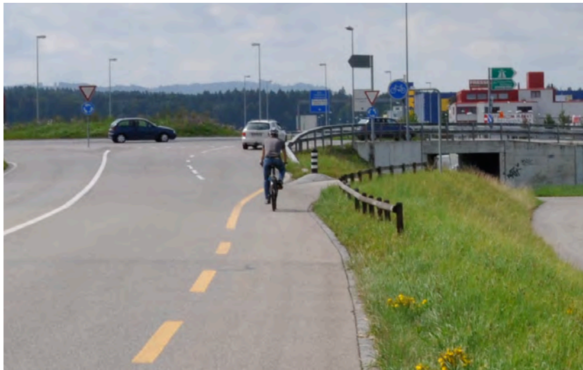
Von Radstreifen zu Radweg: Der Veloverkehr wird kreuzungsfrei um den zweistreifigen Kreislauf geführt.
