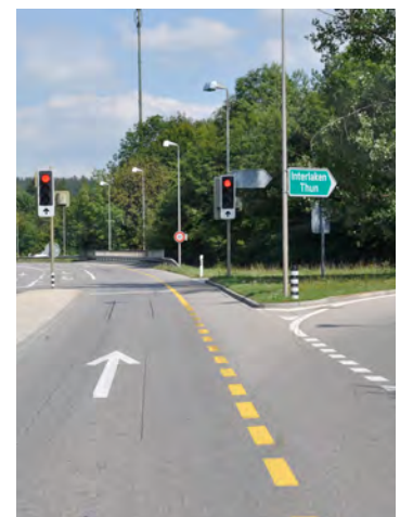
Durchgezogene Radstreifen, Rechtsabbiegestreifen zur HLS im Additionsprinzip.
