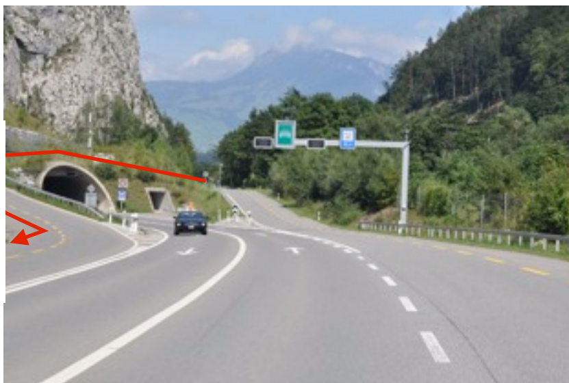
Nœud secondaire sans carrefour et sans traversée de la chaussée (bon exemple). A gauche, l'entrée: franchissement dénivelé pour les cycles, la bande cyclable est aménagée en décrochement par rapport à la voie TIM (pas visible sur l'image). A droite, la sortie: les cycles suivent la bande cyclable et ne peuvent ainsi se retrouver sans le vouloir sur la RGD.
