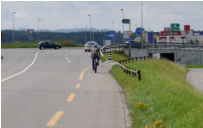
Bande cyclable -> piste cyclable : un franchissement dénivelé permet d'éviter le giratoire à deux voies.
