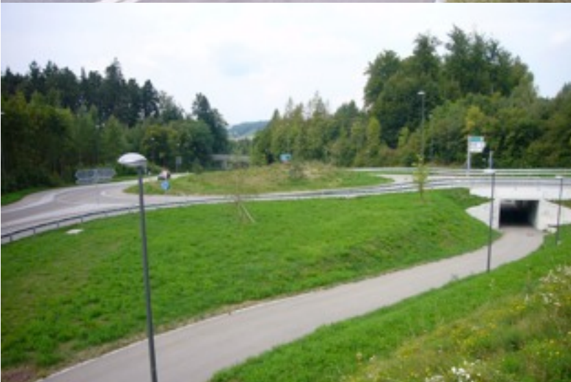
Cycles hors de la circulation automobile, franchissement de la jonction d'autoroute par un passage inférieur
