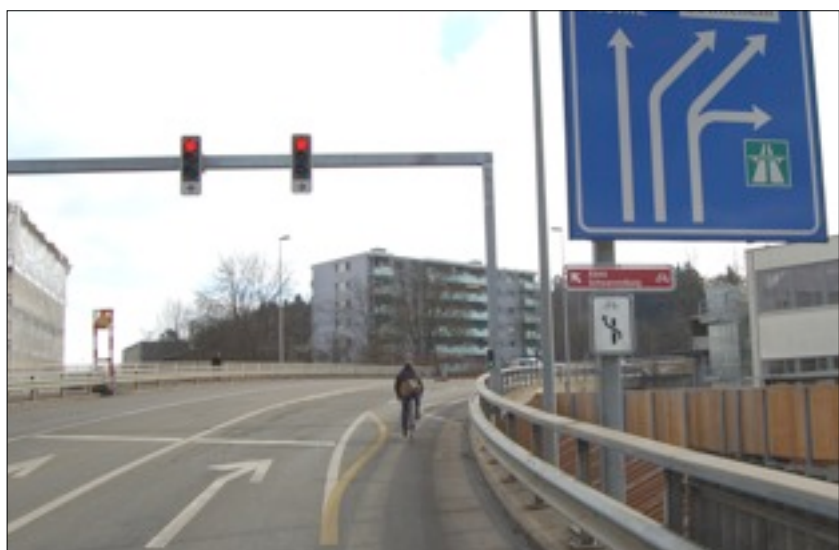
Signalisation lumineuse de la traversée du carrefour pour les cycles, qui doivent aller tout droit. Solution pertinente pour des charges de trafic ne dépassant pas les 5000 véh/j; au-delà, l'attente pour les cyclistes devient trop longue.
