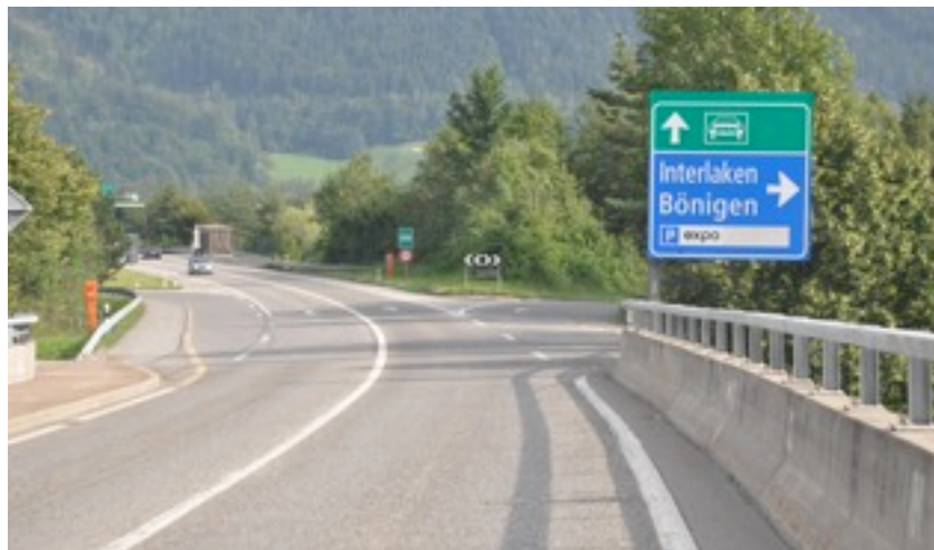
Nœud secondaire sans carrefour et sans traversée de la chaussée (mauvais exemple, cf. p. 11)
