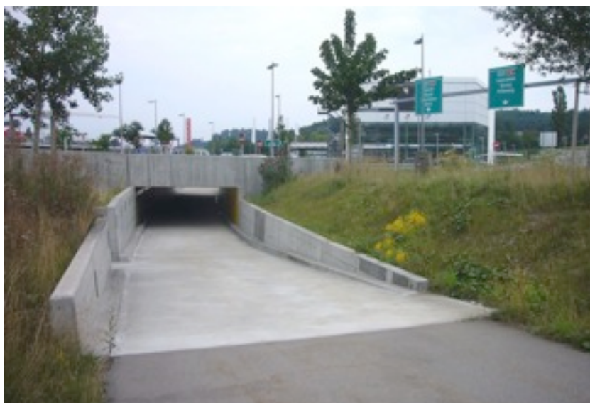
Franchissement dénivelé de la RGD
