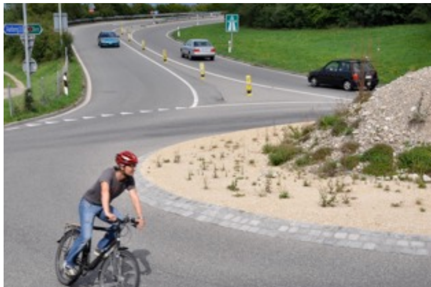
Perte de priorité (ici sous la forme d'un giratoire) pour la sortie de la RGD : sécurité accrue pour les cycles.
