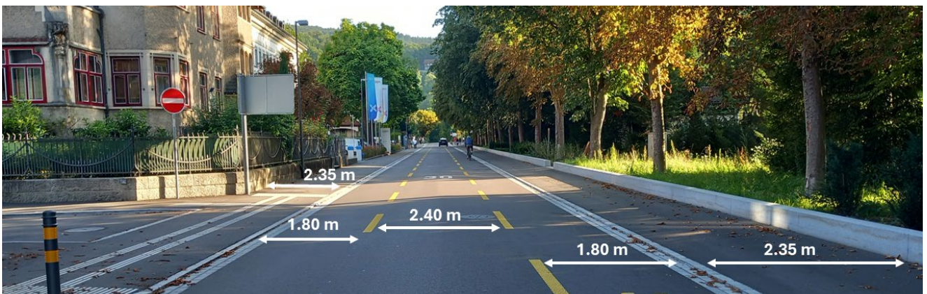
Abb. 2: Parkstrasse Blickrichtung Bäderquartier 2025 nach dem Umbau: Tempo 30, zwei Velostreifen je 1.80 m und schmaler Kern 2.40 m, Trottoir am Rande des Kurparks (Foto: Stadt Baden)
