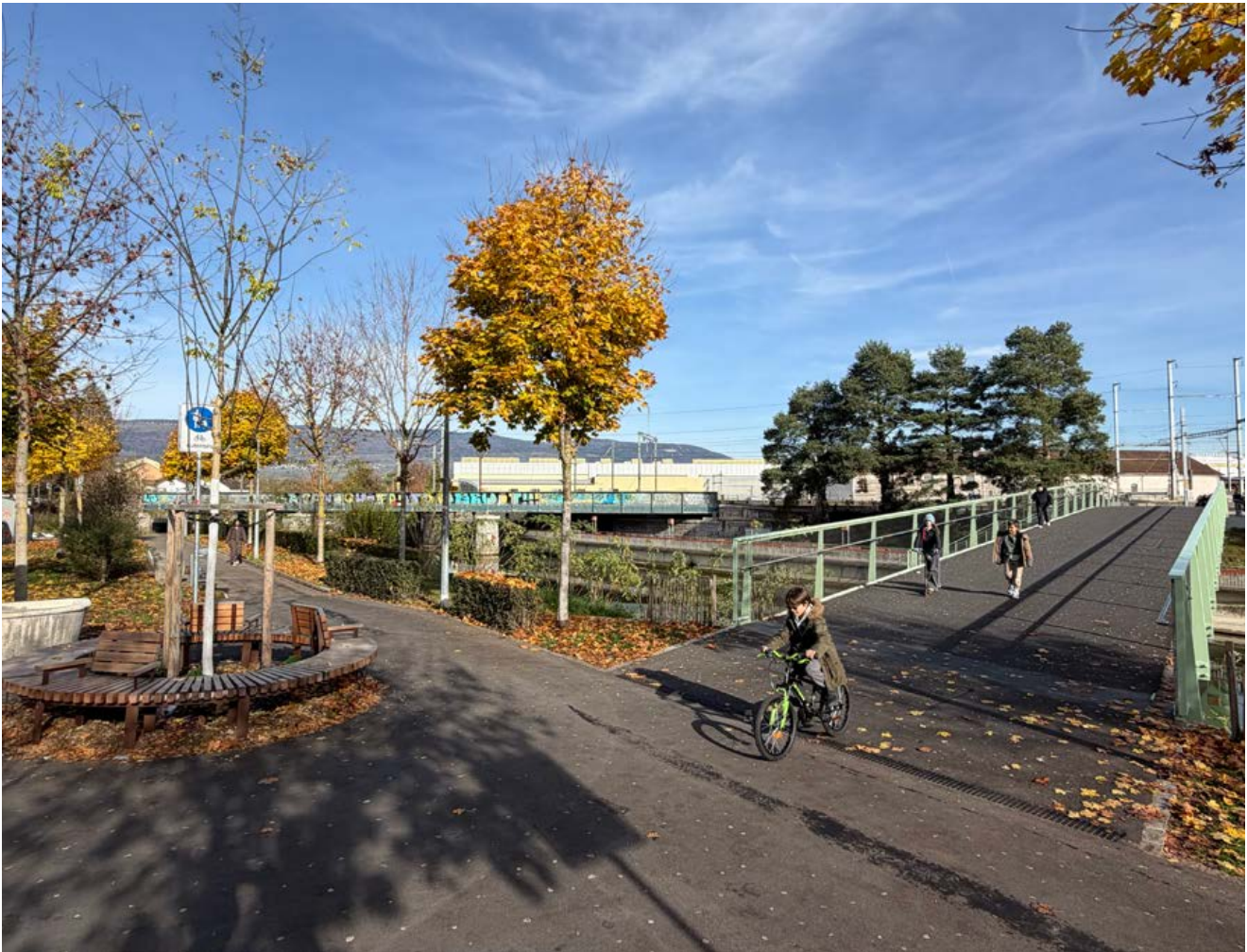
Die Passerelle des Cigarières in Yverdon verbindet den Bahnhof von Yverdon mit umliegenden Wohnquartieren und ermöglicht so dem Velo- und Fussverkehr eine sichere Querung der Thièle. (Foto: Laurent Duthell)
