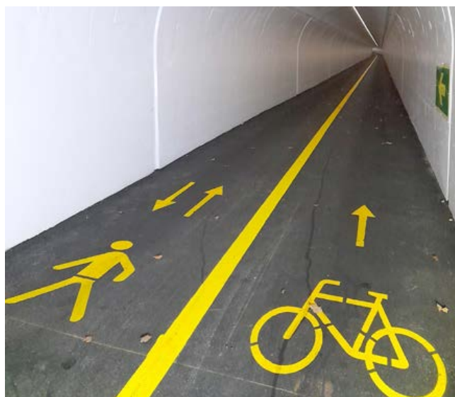
Der Tunnel war auch schon als Infrastruktur des Monats auf der Website roadmapvelo.ch aufgeführt: roadmapvelo.ch/infrastruktur-des-monats/sicherheitsstollen-la-clusette/ . (Foto: Tiefbauamt, Kanton Neuenburg)
