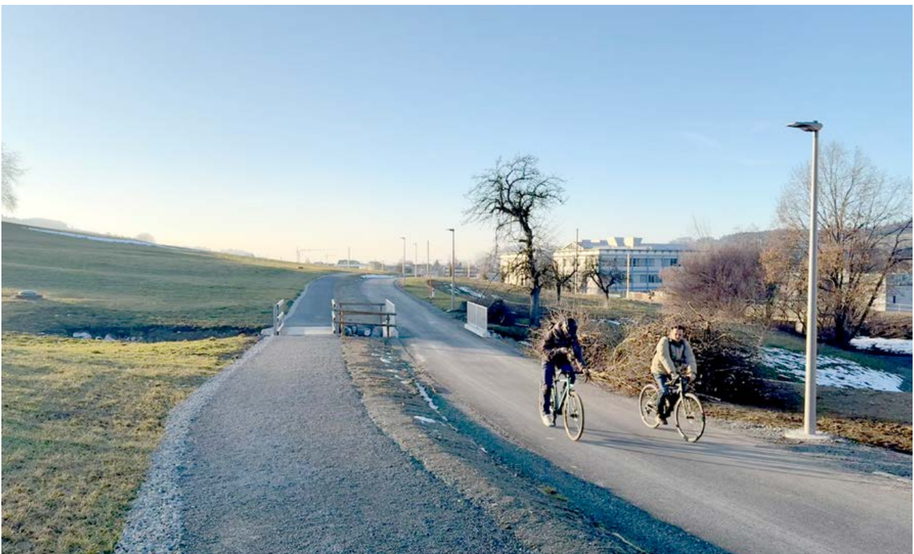
Rohbau Neuhofweg mit getrennter Fuss- und Veloinfrastruktur (Foto: Stadt St.Gallen)
