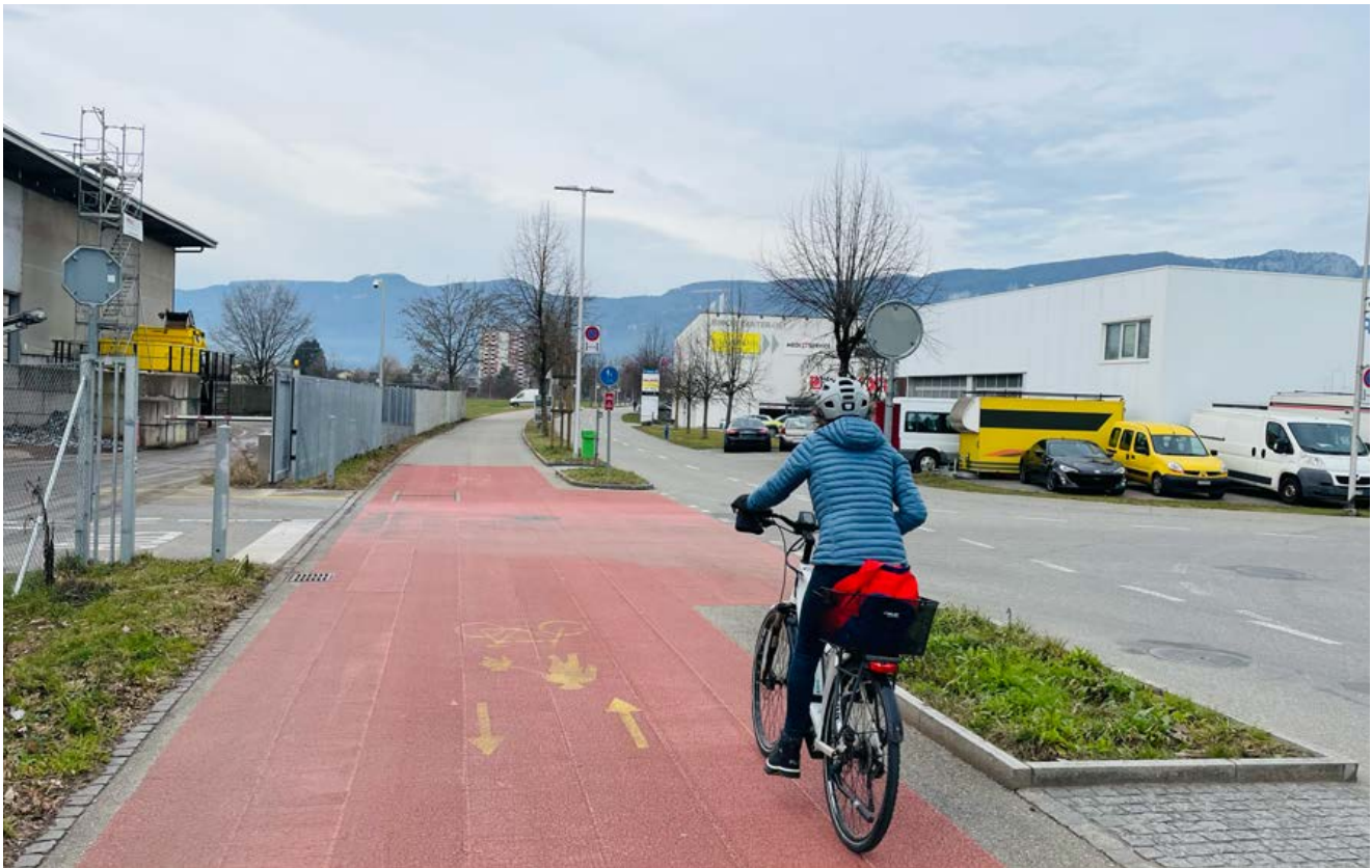
In der Agglomerationsperipherie von Solothurn wurde ein vom Auto- und Schwerverkehr abgetrennter Fuss- und Zweirichtungsradweg angelegt. Er ist genügend breit, um das Kreuzen und das Überholen langsamerer Velos zu ermöglichen. (Foto: Laurent Duthéil)
