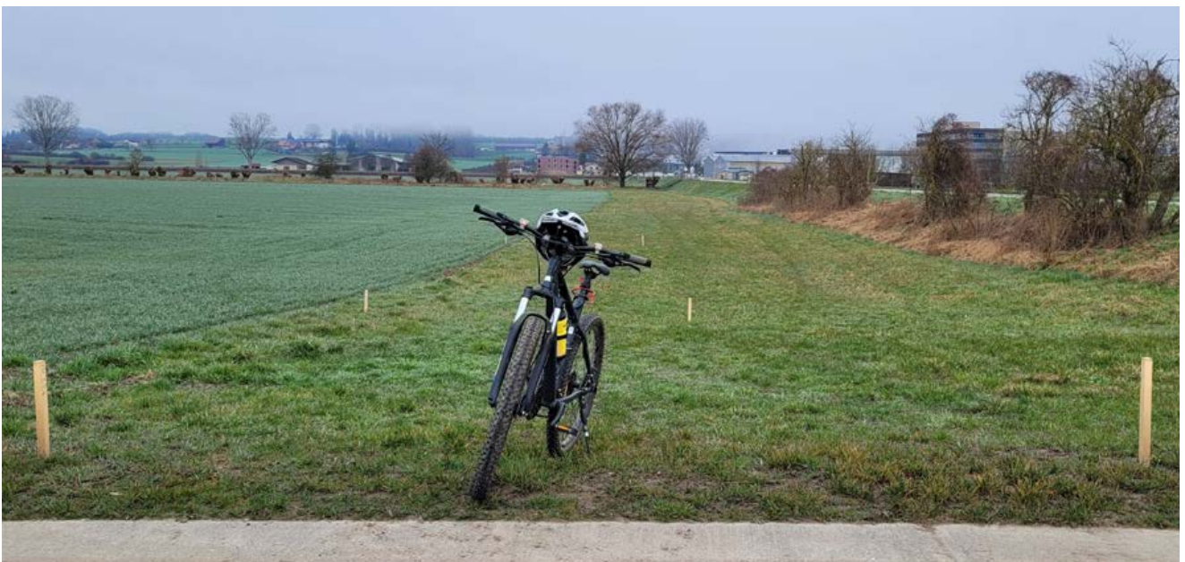
Absteckung des geplanten Velowegs zwischen Saint-Aubin und Domdidier. Der Weg verläuft teilweise abseits der Strasse, um die geschützte Baumreihe zu erhalten. (Foto: TBA, F. Collaud)
