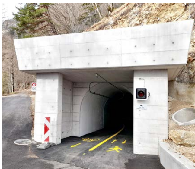
Der ausgebaute Sicherheitsstollen des Tunnels von La Clusette befindet sich im Val-de-Travers, Kanton Neuenburg (Link zum Ort: sitn.ne.ch/s/lkh7 ). (Foto: Tiefbauamt, Kanton Neuenburg)
