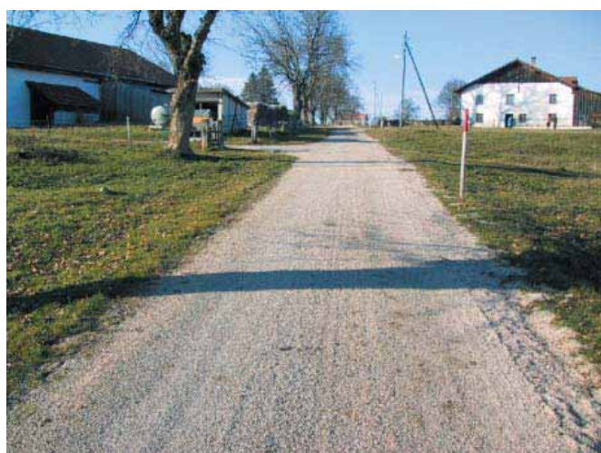
Kalkhaltiger Splitt 2schichtig / Gravillonnage calcaire bi-couche
