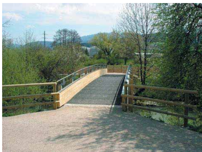
Neuer Steg über / Nouvelle passerelle sur La Sorne
