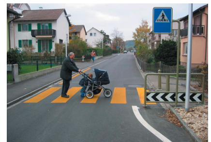
Aesch/BL, sécurité routières
