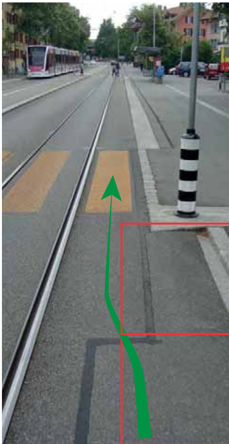
Fugenlage akzeptabel an der Haltestelle Steigerhubel
