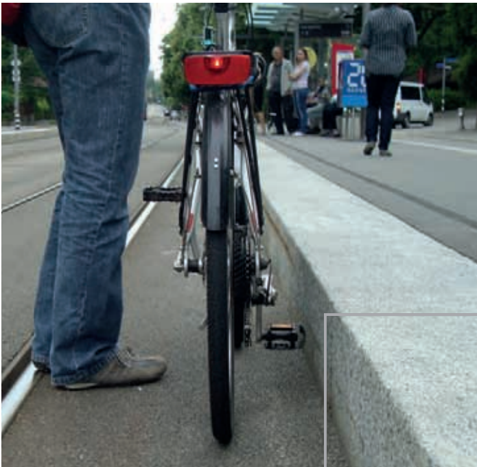
arrêt central avec bord haut et peut d'espace entre le rail et l'arrêt
