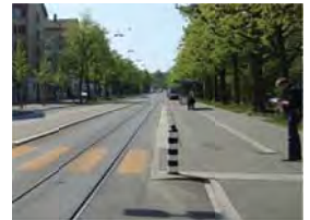
Haltestelle Schlossmatte: Abgrenzung Haltestellenbereich durch Randsteine
