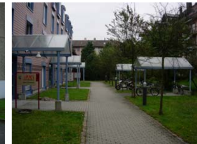
Façade datant de 2000
